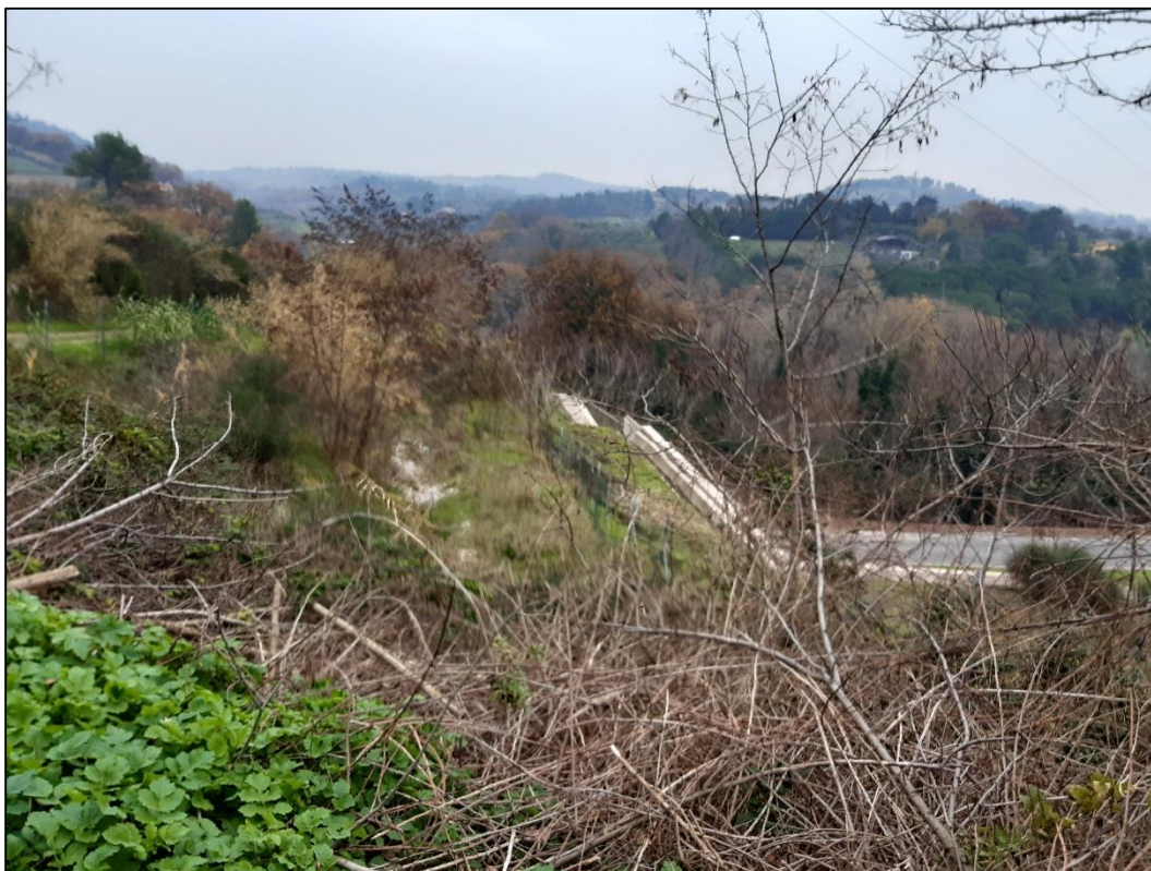
Figura 1-3: imbocco sud, canna nord, della galleria con terreno ricostituito, idrosemina, impianti arbustivi realizzati e rete di regimazione delle acque meteoriche realizzate
