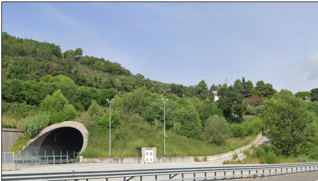
Figura 6-4: ambito 2 di intervento all'imbocco sud canna sud, ripreso dall'A14 carreggiata nord
