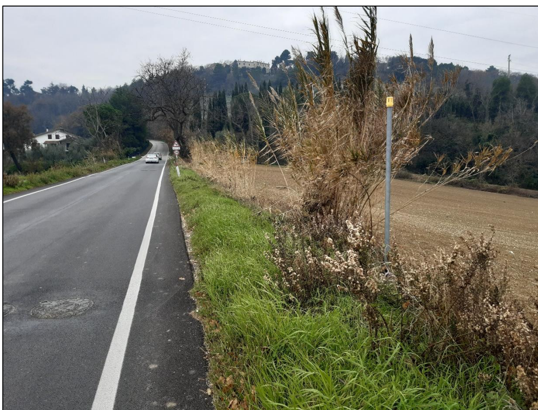
Figura 6-1: ambito 1 di intervento sulla destra della SP60 (foto ripresa sulla provinciale verso sud)
