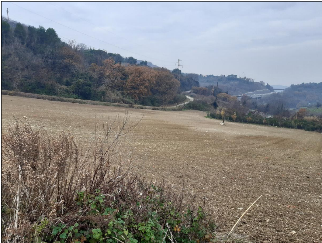
Figura 1-4: riporto di un adeguato orizzonte di terreno vegetale (circa 50 cm) su tutti i versanti ricostruiti realizzato
