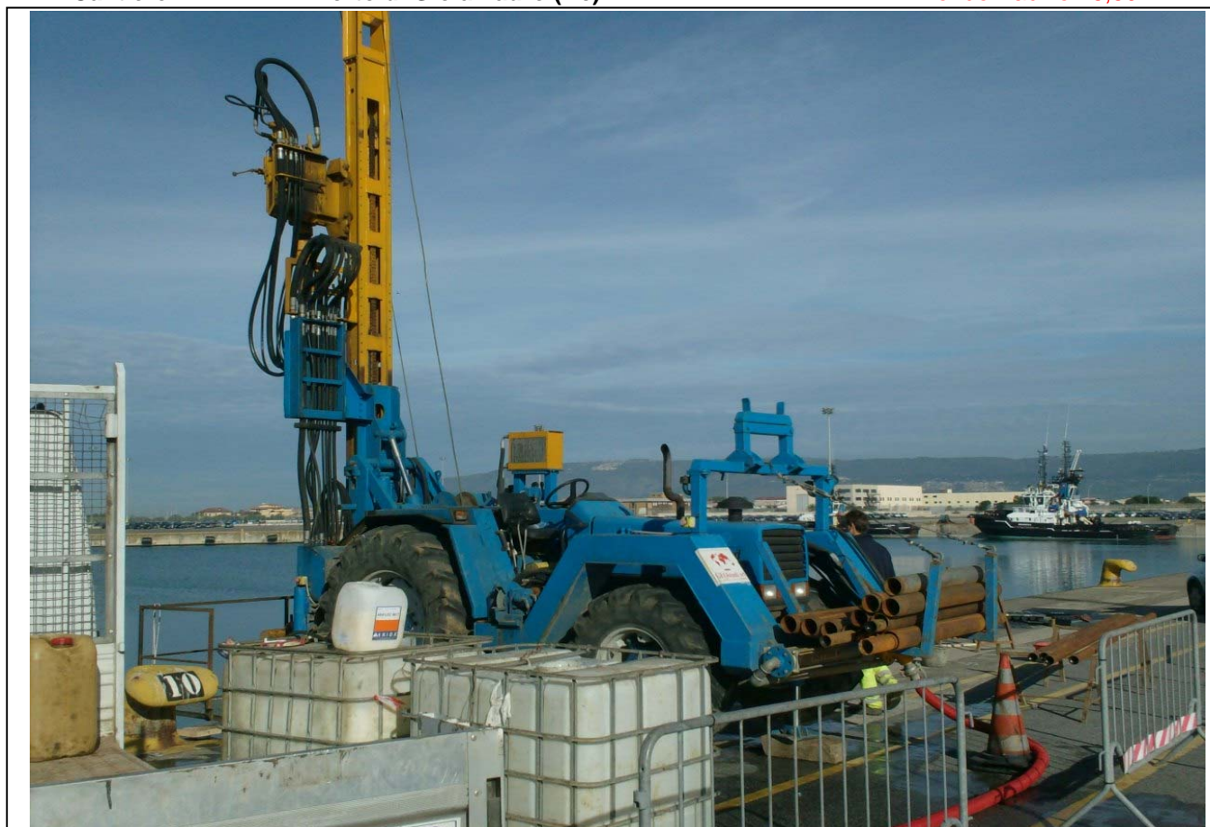
SONDAGGIO S8M- POSTAZIONE
