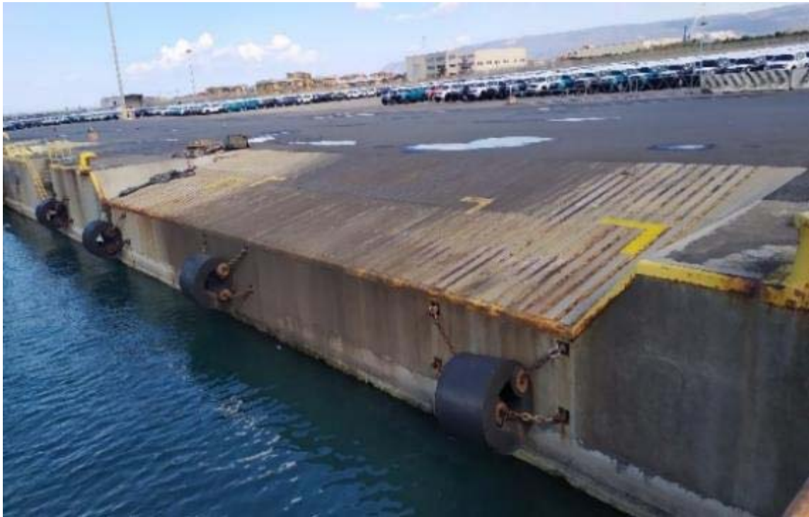
Figura 22 Primo scivolo banchina tratto E
