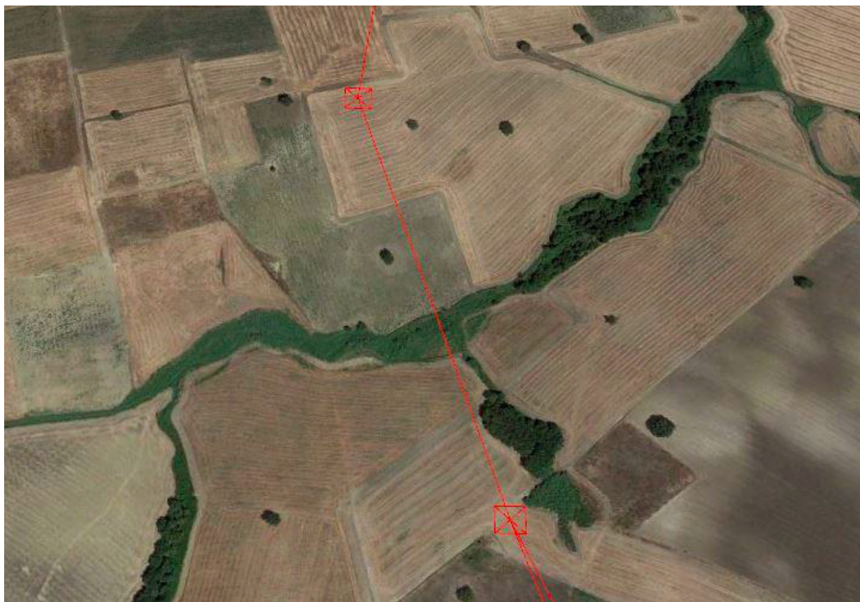
Immagine 6 - Attraversamento dell'elettrodotto sul Torrente Mannara
