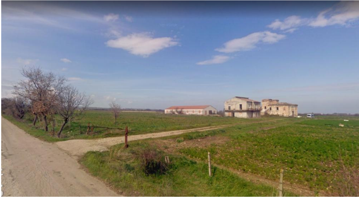
Foto 02 - Vista della Masseria Sassi Grande oggetto di demolizione in quanto inclusa nel perimetro di intervento
