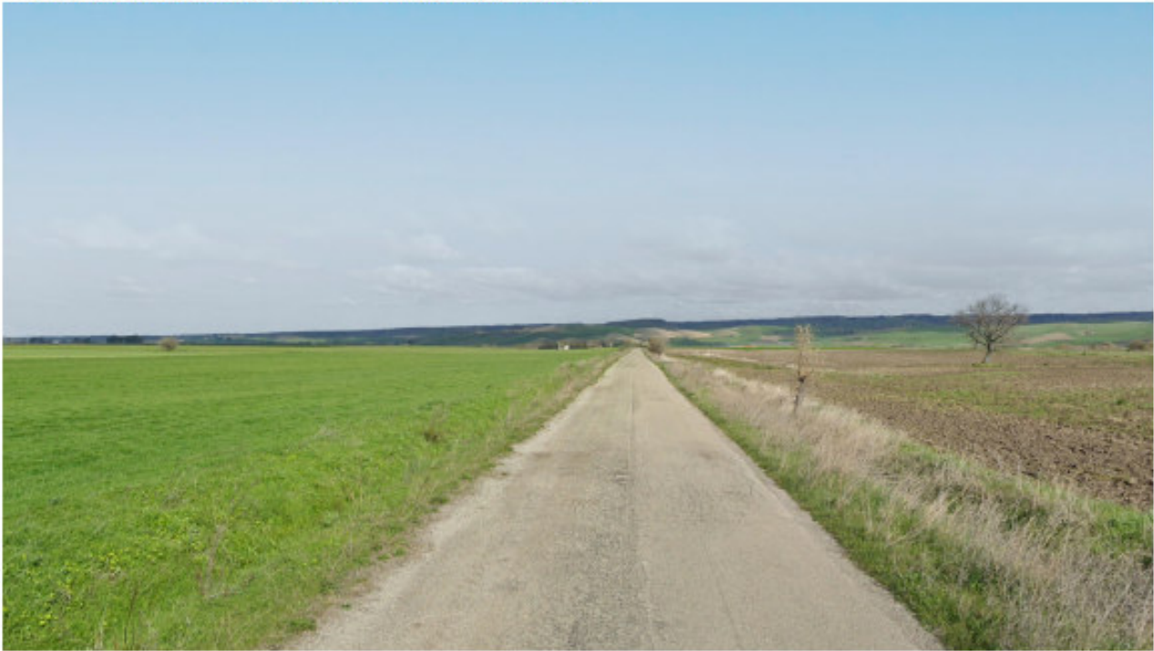
FOTO 3: STATO DI PROGETTO - POST OPERAM
