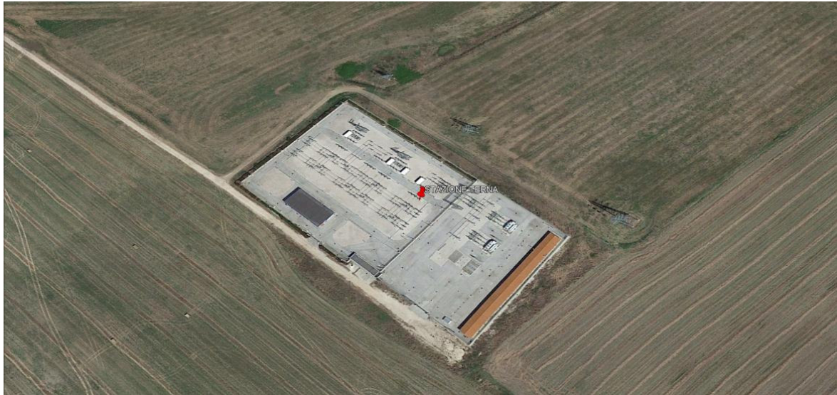
Vista stazione Terna RTN a 150 kV già esistente a San Martino in Pensilis
