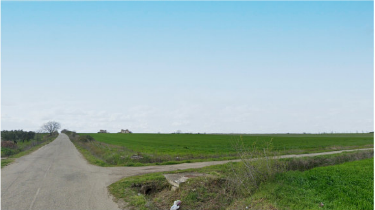
FOTO 2: STATO DI PROGETTO - POST OPERAM
