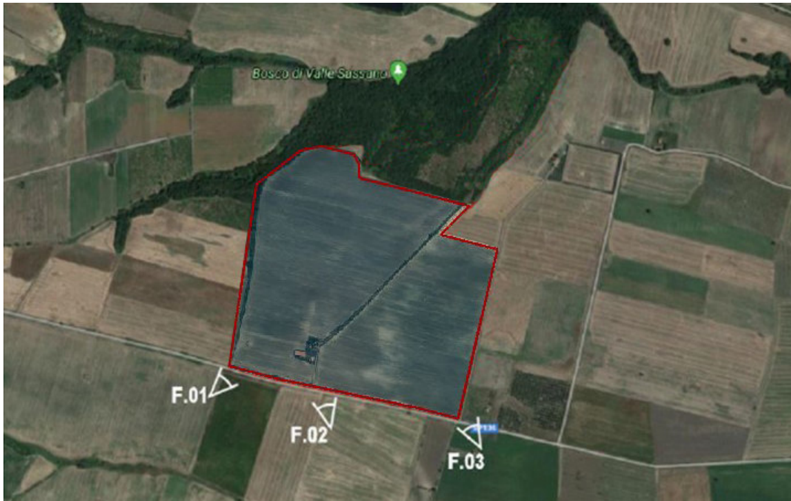
Vista d'insieme con i punti di scatto dell'area di cui al FG 36
