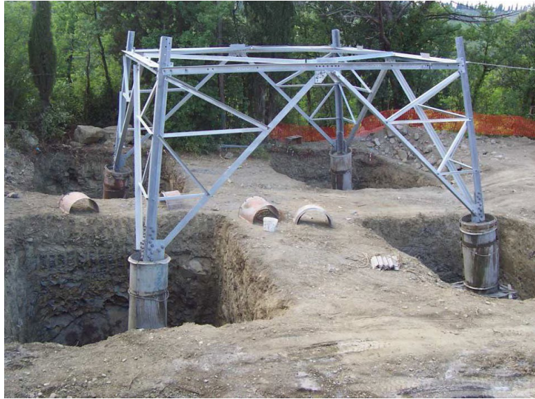
Figura 19: realizzazione di fondazioni superficiali tipo CR per un sostegno a traliccio. Nell'immagine si possono osservare le quattro buche, la base del sostegno collegata alla fondazione tramite i "monconi" ed i casseri utilizzati per i quattro "colonnini" (immagine d'archivio)
