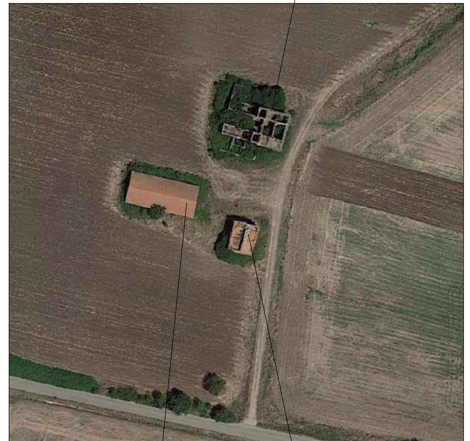
C - rudere non censito in catasto UNITA' DA DEMOLIRE
