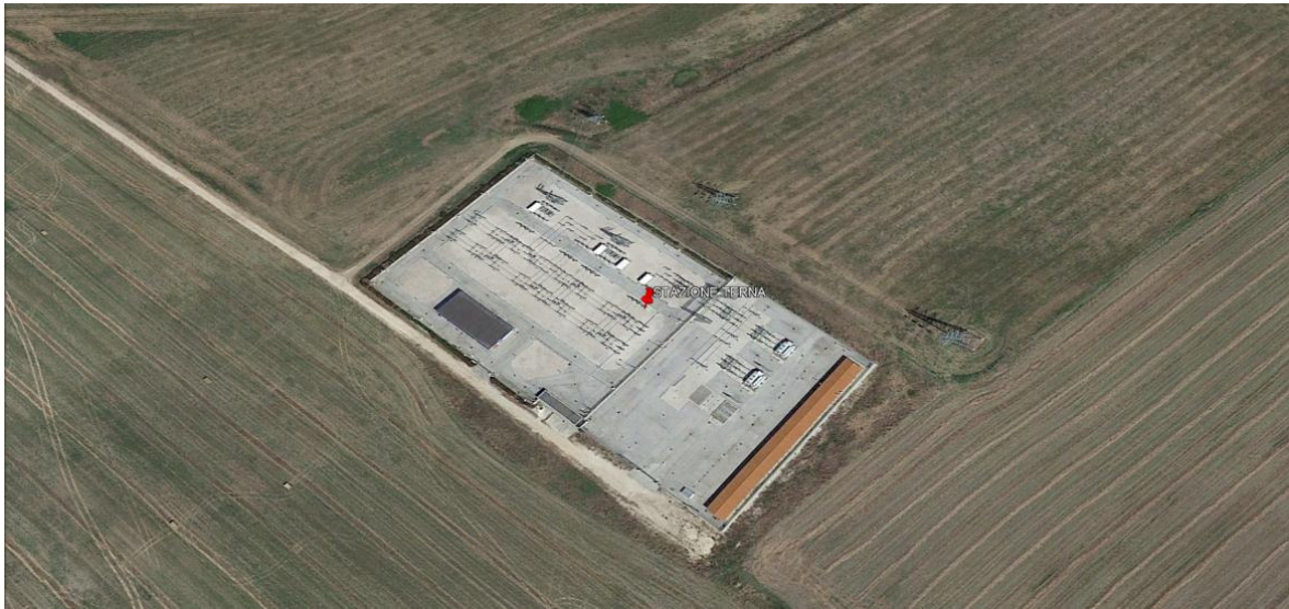
Figura 5-5 Vista stazione Terna RTN a 150 kV già esistente a San Martino in Pensilis
