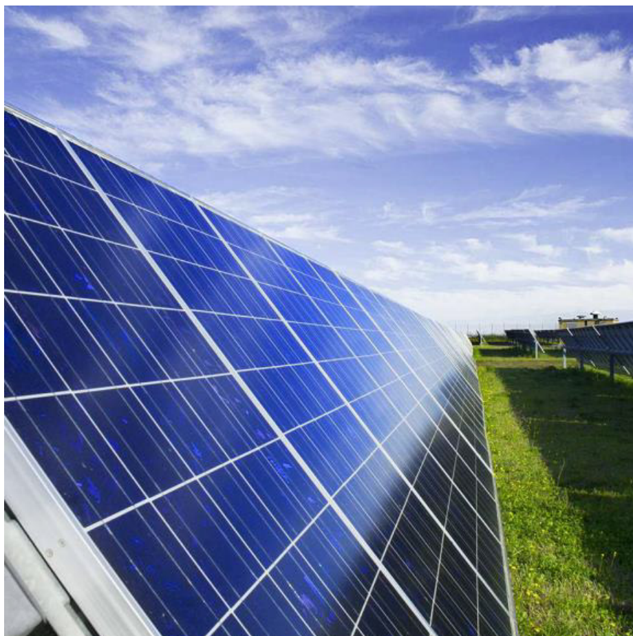
Figura 5-2 – Tipico tracker fotovoltaico in configurazione "1-Portrait"
