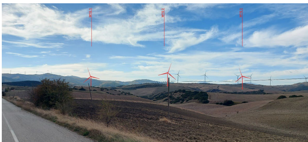
Rendering di progetto con l'indicazione a diversa tonalità di colore – Punto di presa fotografica 9a
