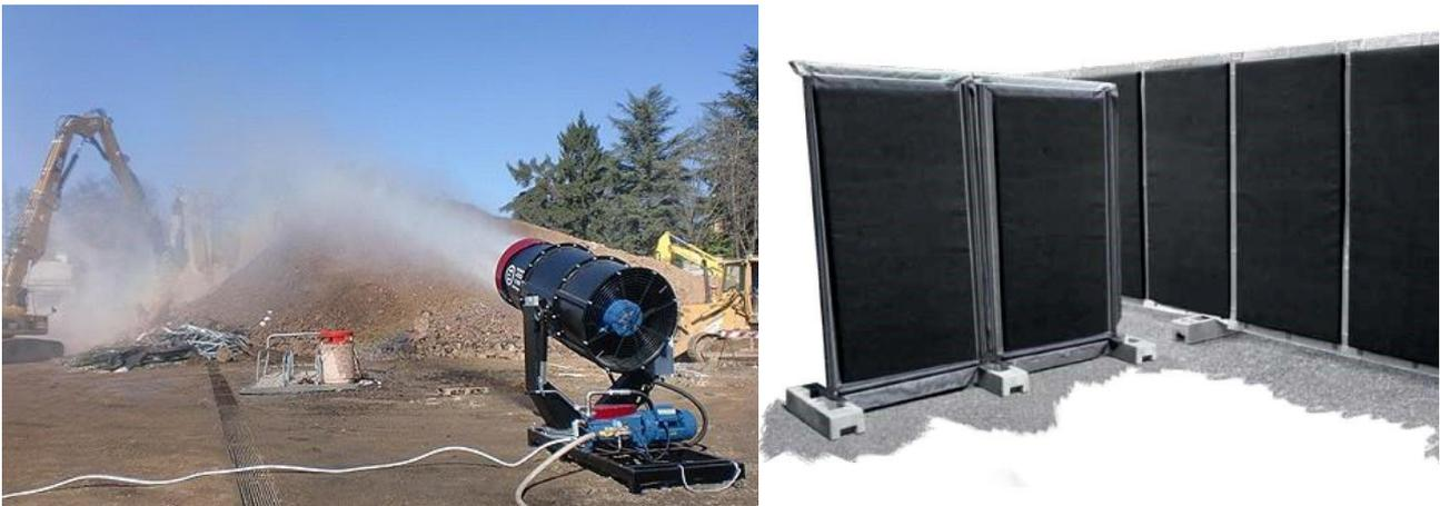
Figura 16: Esempi di misure di mitigazione (nebulizzatore fog cannon e barriere antirumore)
