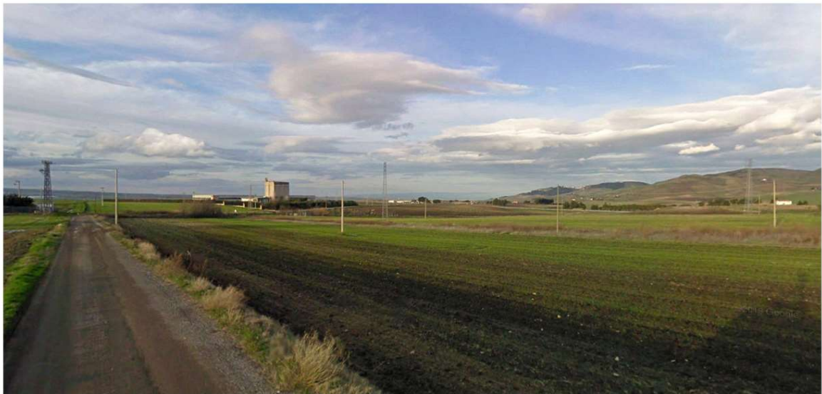
Figura 8: Documentazione fotografica dell'area destinata ad ospitare l'impianto
