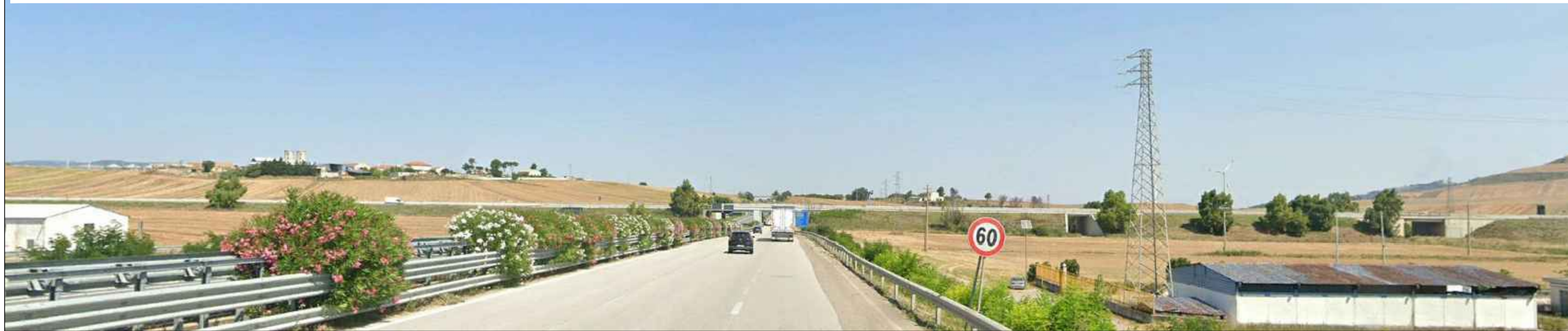
PUNTO 7 - STATO DI FATTO
