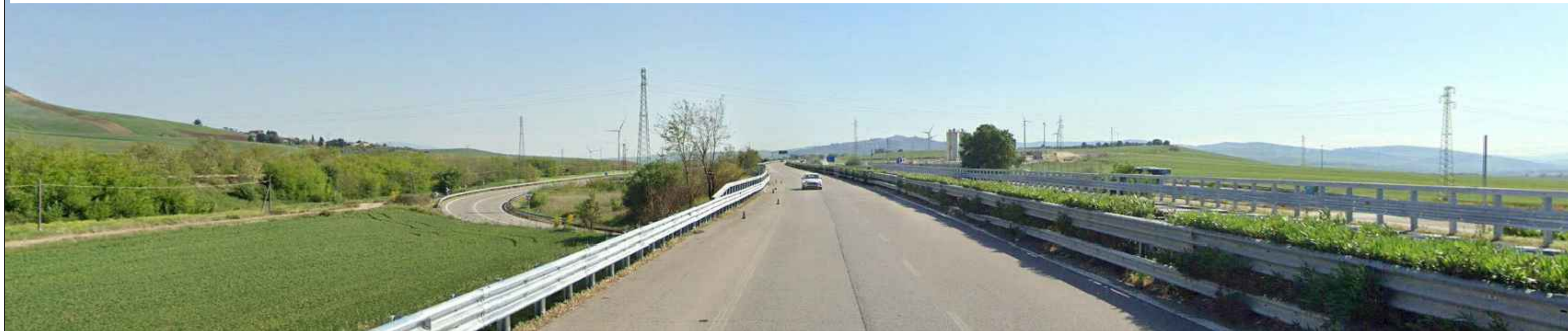
PUNTO 3 - STATO DI FATTO
