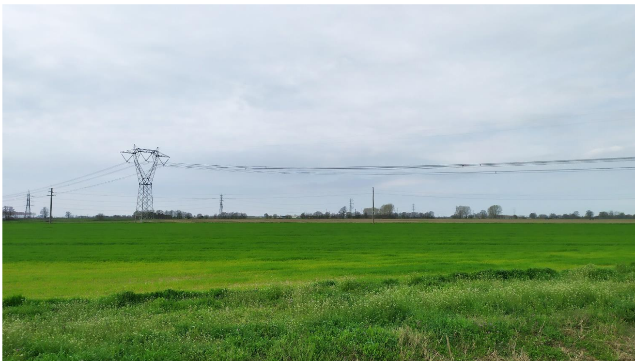
Figura 4-3. Vista 01 – Stato di fatto.
