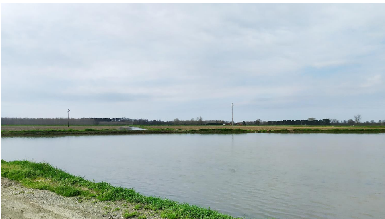
Figura 4-9. Vista 04 – Stato di fatto.
