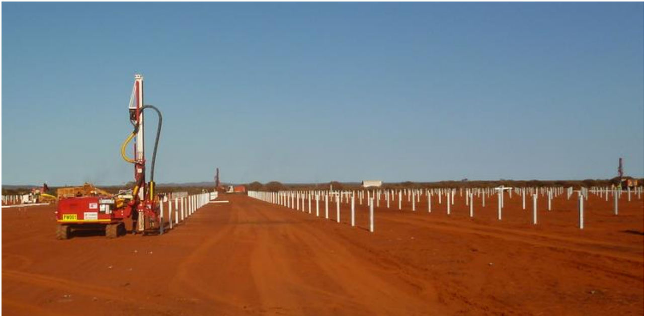
Figura 37: Infissione sostegni a mezzo di battipalo
