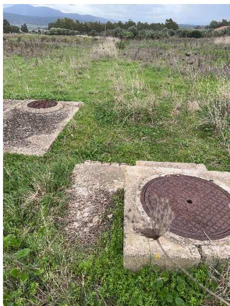
Figura 4.10: Condotta - Punto di presa fotografica 9.
