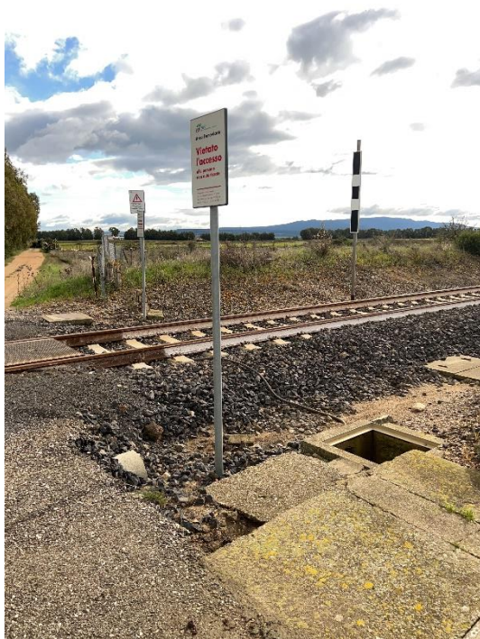
Figura s03.c: attraversamento strada
