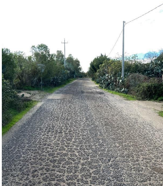
Figura i09: fosso interrato lato strada
