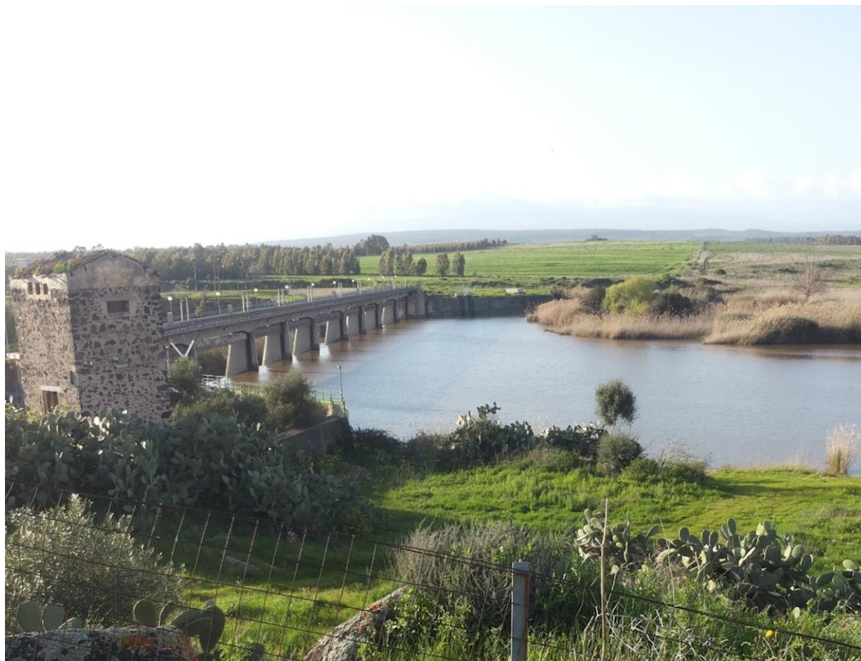
Figura 2.2: Il Fiume Tirso e la Diga Santa Vittoria nei pressi dell'area in esame
