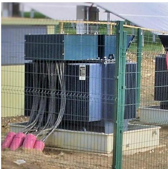
*Figura 4.3: Esempio di vasca di raccolta*
