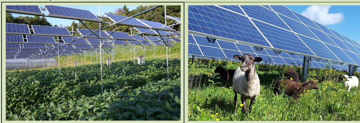
Figura 1.1: Esempi Impianti Agri-voltaici
