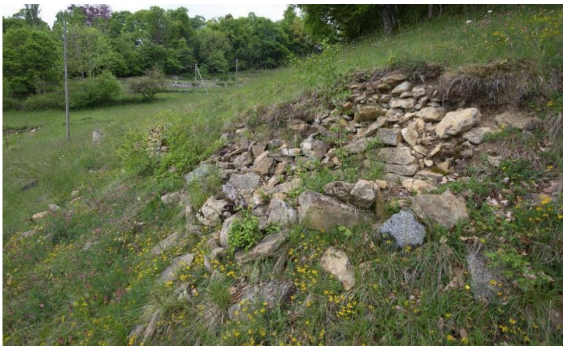
Figura 5.7: Particolarmente attraenti per i rettili sono i luoghi in cui un vecchio muro a secco presenta dei danni. Qui l'incastro di pietre e vegetazione è massimamente pronunciato e gli animali trovano delle condizioni ideali. (Meyer, 2023).
