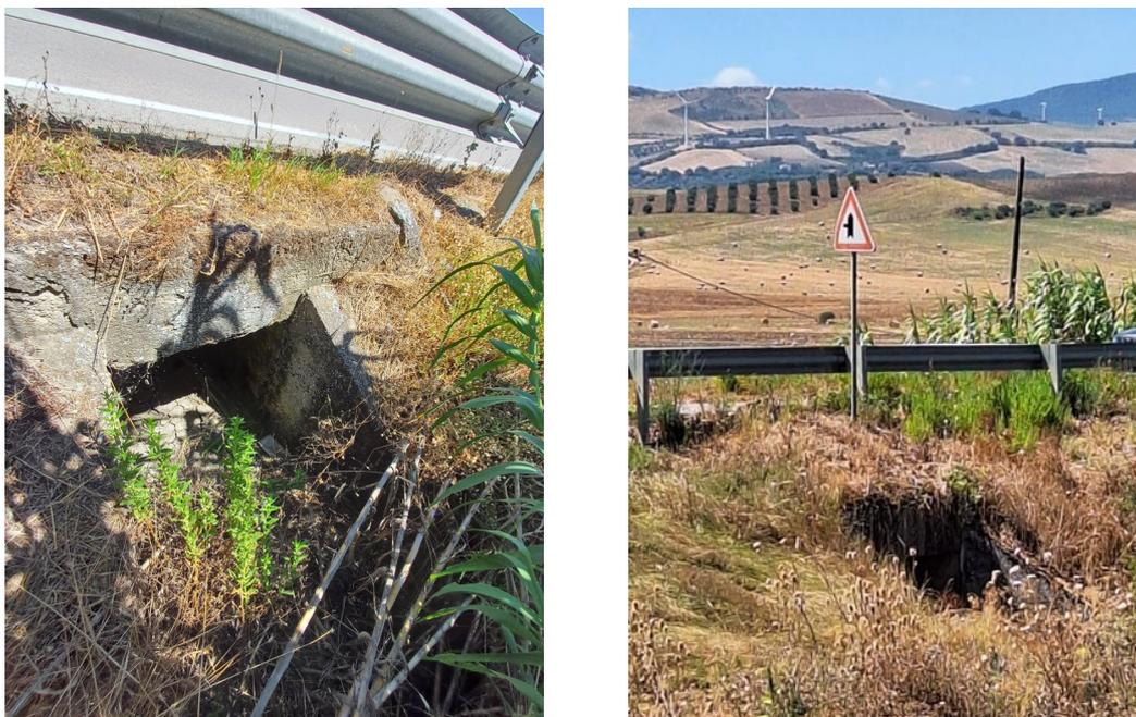
Figura 39 - Canali di raccolta I1 e I2
