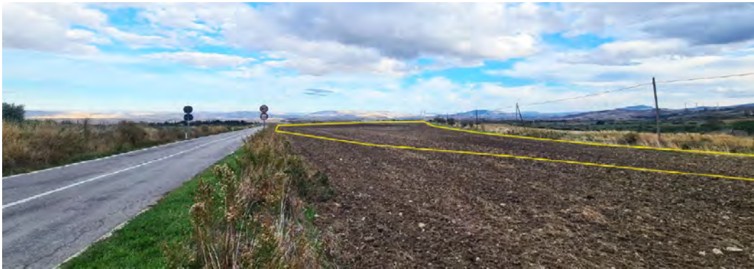
Figura 121 - Vista 11: Stato Ante Operam
