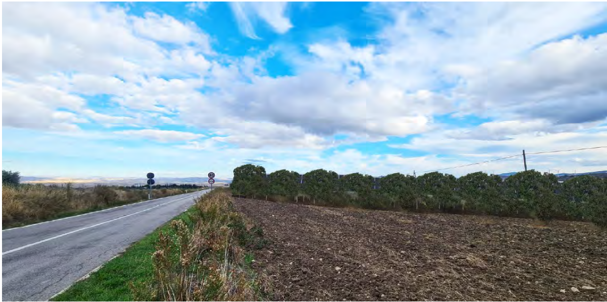
Figura 123 - Vista 11: Post Operam con opere di mitigazione
