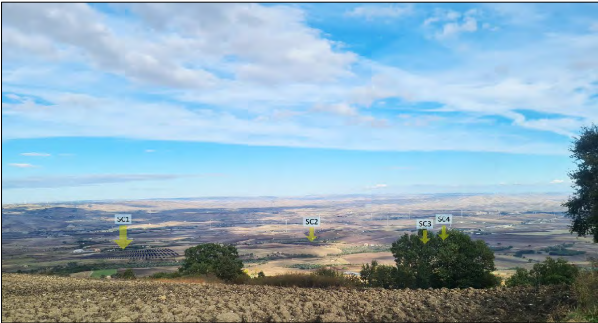
Figura 96 - Punto panoramico, post operam
