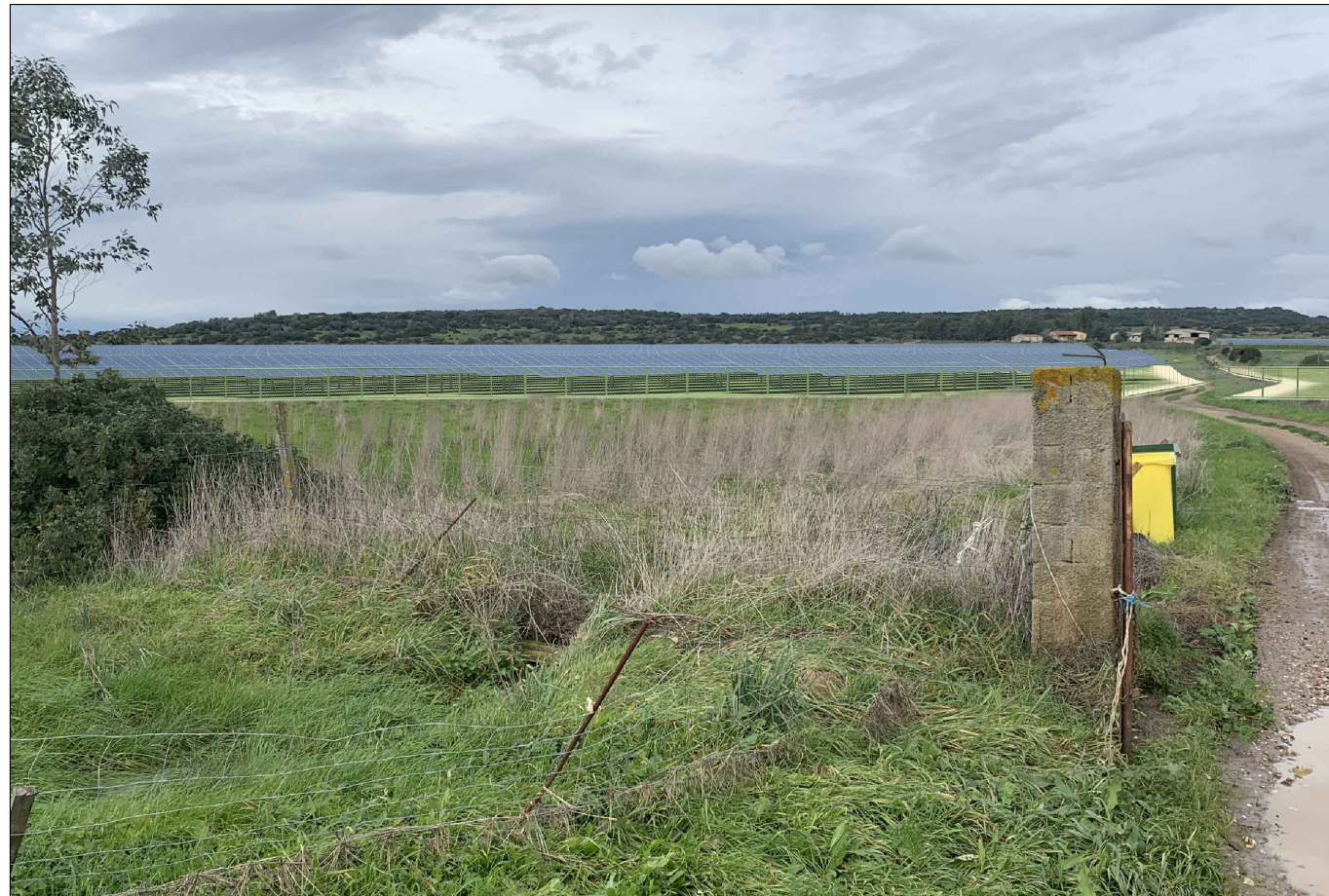
VISTA DA PUNTO BERSAGLIO 02 - POST OPERAM
