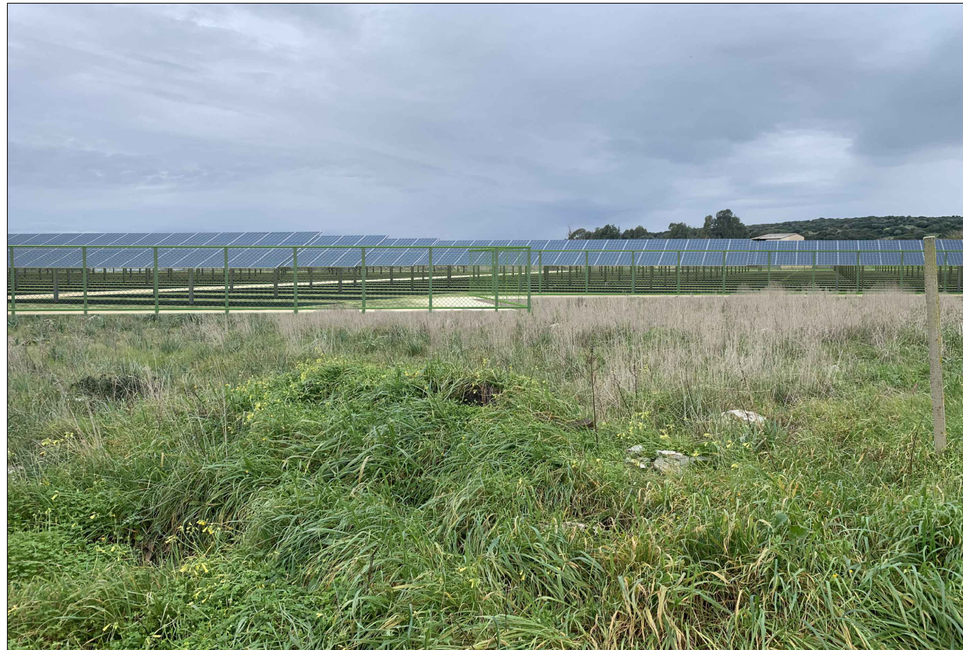
VISTA DA PUNTO BERSAGLIO 05 - POST OPERAM
