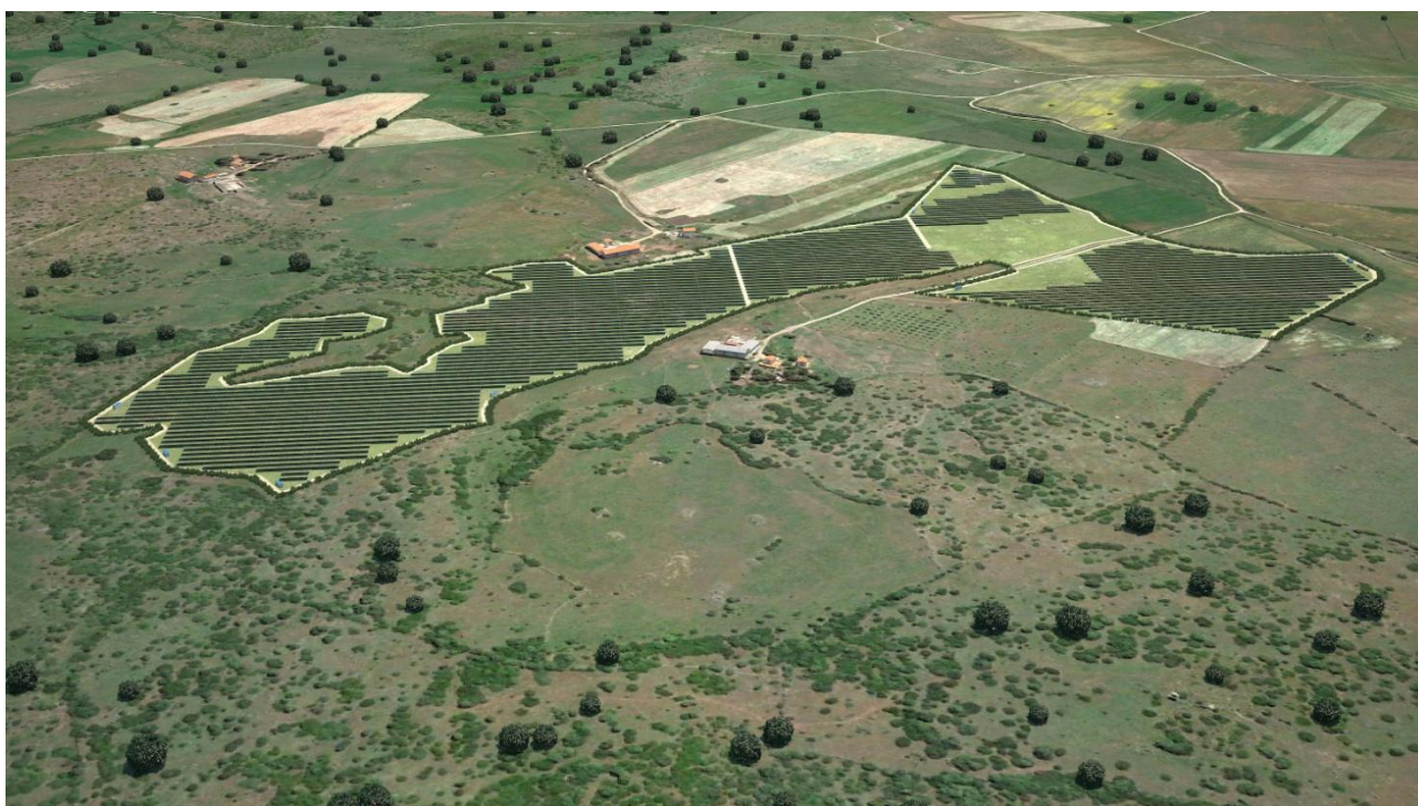
Figura 57: Vista D Post operam.
