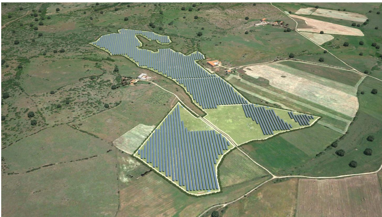
Figura 51: Vista A Post operam.
