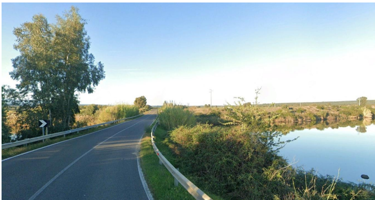
Figura 27: Punto Bersaglio 3L – SS 388 – Ponte sul fiume Tirso.
