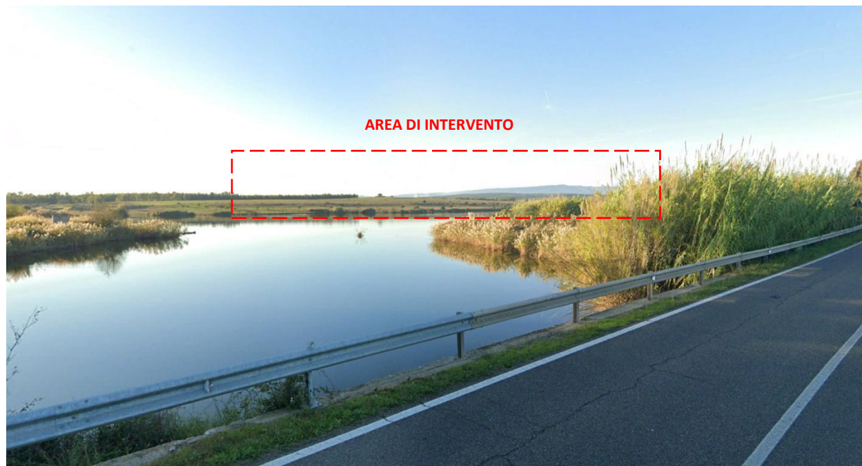
Figura 29: Vista da punto bersaglio 3L in direzione impianto AGV post-intervento.
