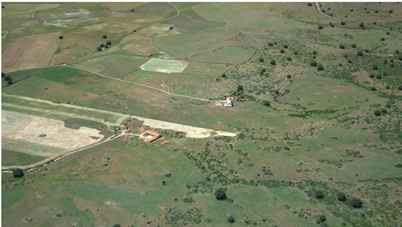
Figura 54: Vista C Ante operam.
