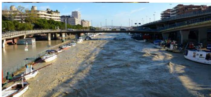
Figura 4-63 -Fiume Pescara: imbarcazioni afferenti alla nautica minore ormeggiate a monte del porto canale durante la piena del 2013.
