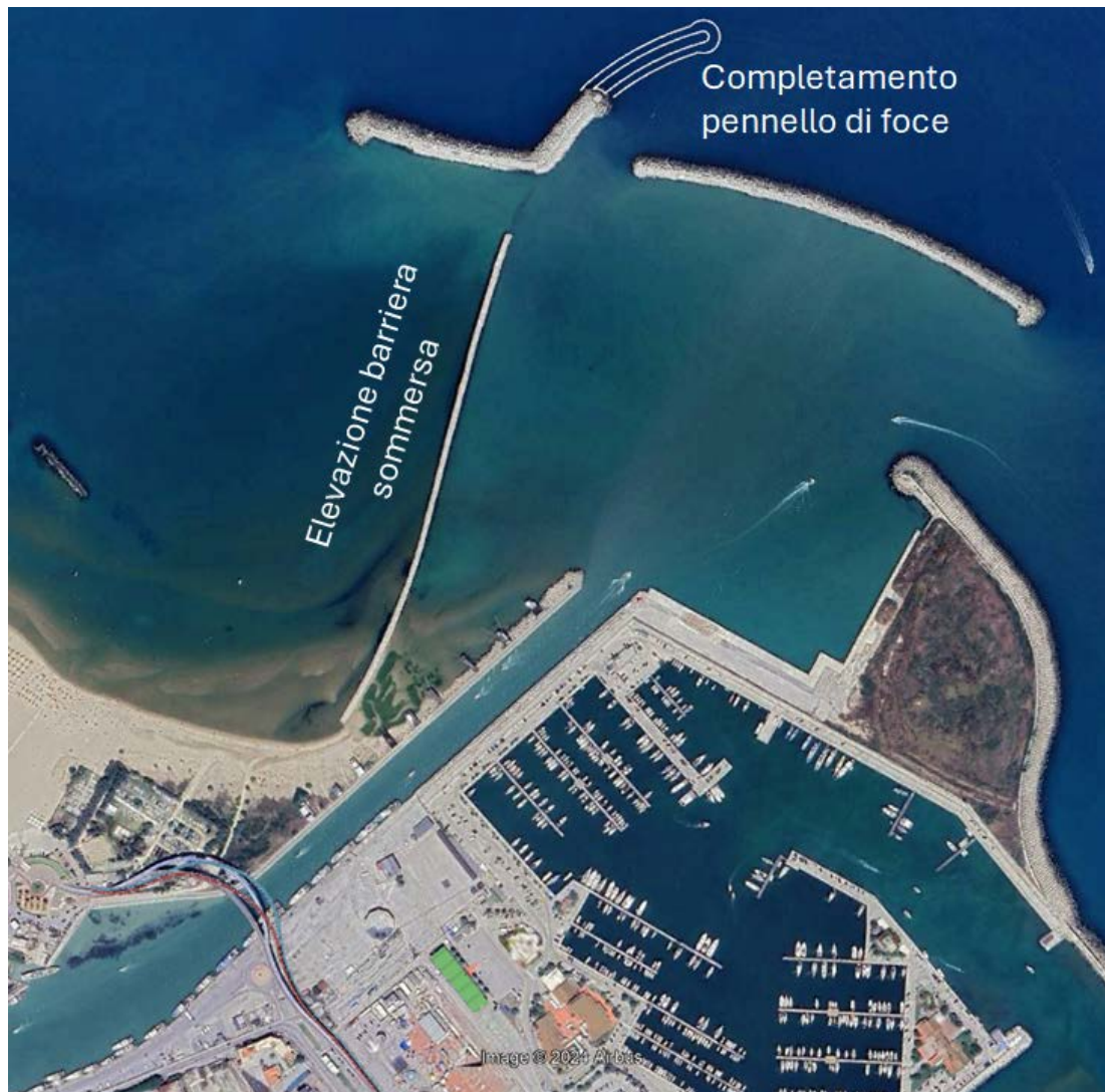
Figura 3-3 – Opere in parte completate ed in parte in fase di completamento da parte di ARAP
