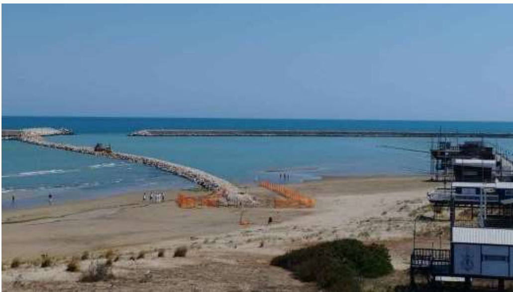
Figura 3 Vista della scogliera di radicamento
