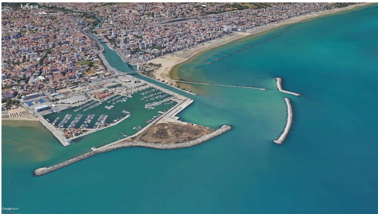
Figura 48 – Vista a volo d'uccello dell'area di intervento nella configurazione attuale
