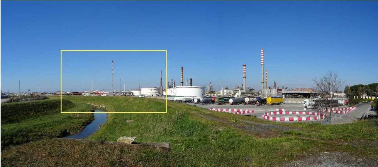
Figura 5: Fotosimulazione dal punto di osservazione localizzato sul ponte di Via Firenze
