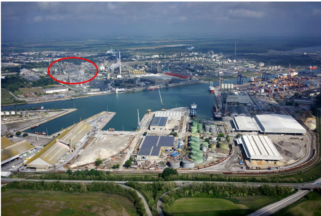
Figura 4.63– Foto aeree Sistema Canale Candiano – Darsena - Zona industriale. In rosso l’area di intervento (Fonte: in alto ravennadomani.blogspot.com, in basso ravennatoday.it)
