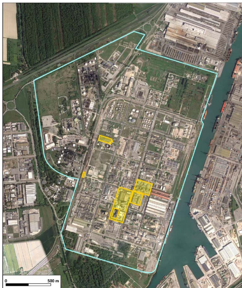
Figura 2.1 - Ubicazione delle aree interessate dal "progetto Peakers" di Ravenna -Sito petrolchimico multisocietario di Ravenna (linea azzurra) e Stabilimento Enipower (evidenziato in giallo)
