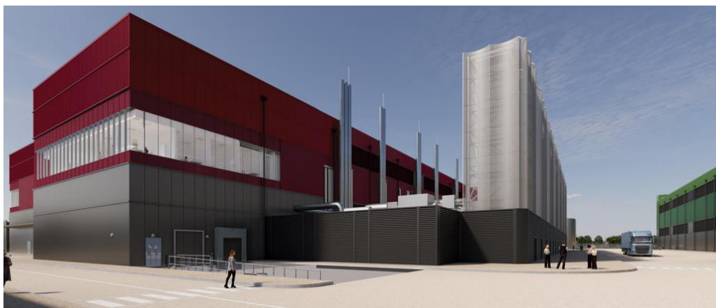
Figura 17 Rendering relativo all'installazione dei louvres acustici mod. Allaway double bank AL3015D presso i generatori
