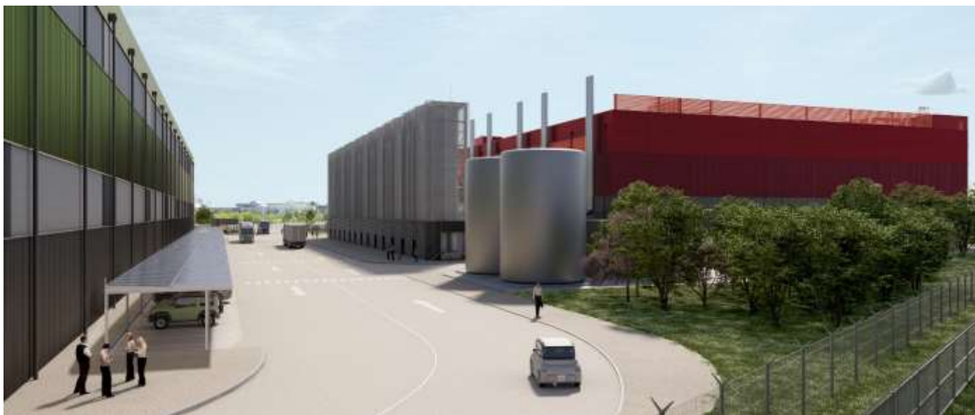
Figure 5.5 Render fronte nord edificio B – sono visibili i louvres acustici in copertura e la quinta che maschera i generatori
