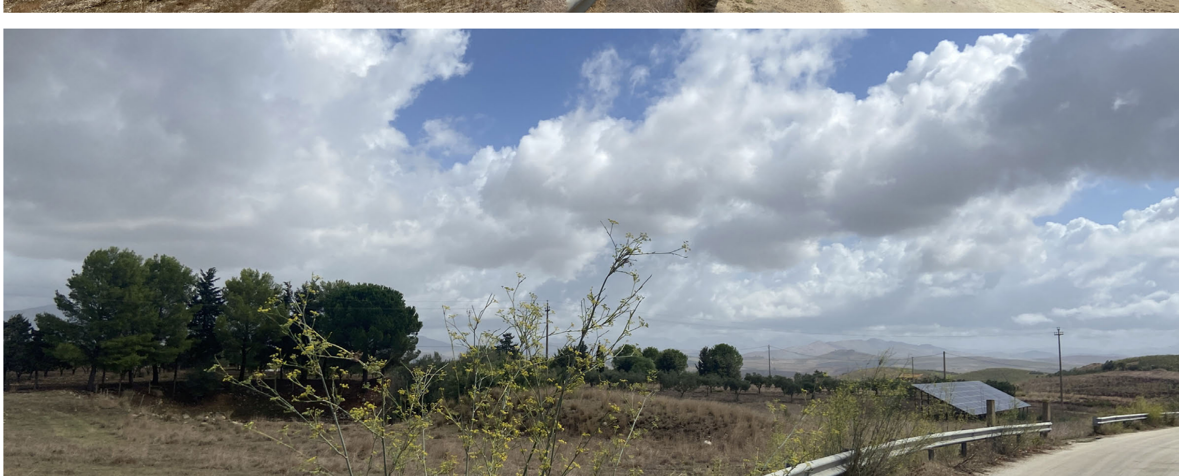
Ripresa fotografica n.6b (in direzione E) eseguita dalla strada Provinciale n. 12 (km 10+600) a 228 m s.l.m., in località Casa Avila, a circa 112 m dai confini di impianto.
