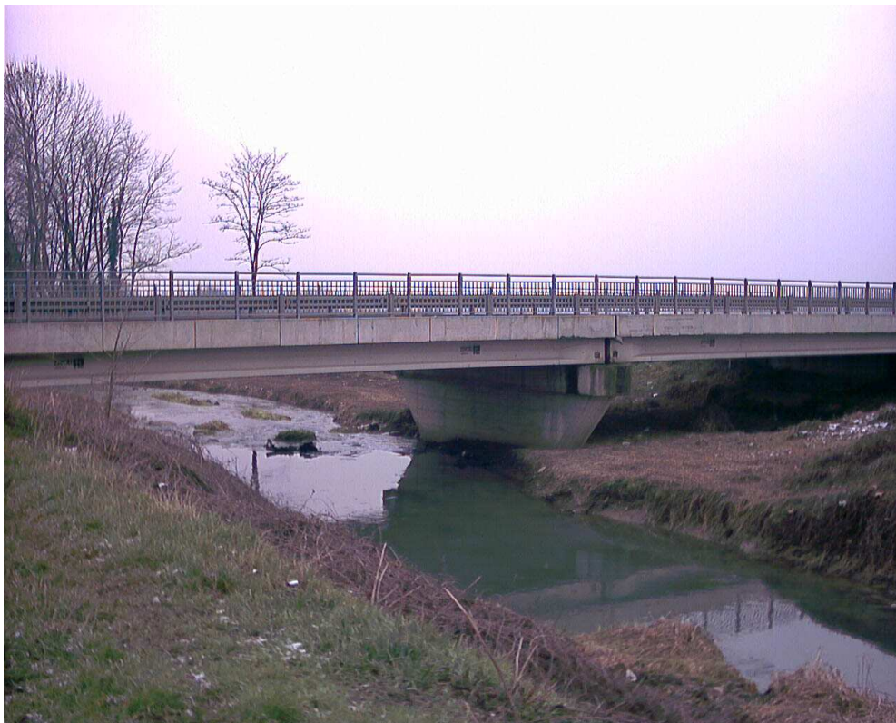
Figura 3– Opera interferente con la situazione attuale prog. 0+072.86
