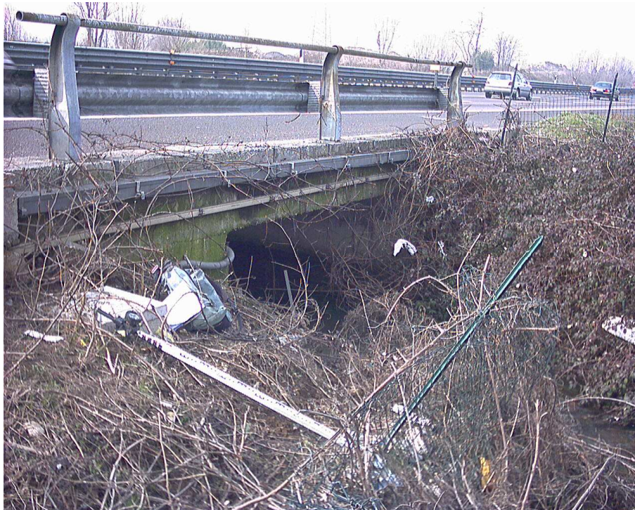
Figura 3– Ponte a solettone sull'autostrada A.4. prog. 0+124.02
