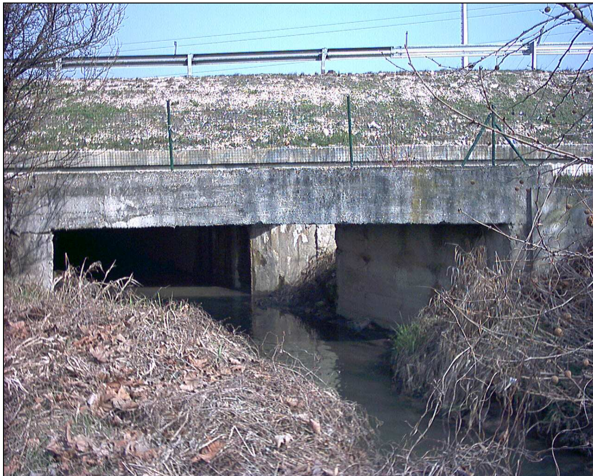
Figura 4 – Ponticello a valle dell'autostrada
