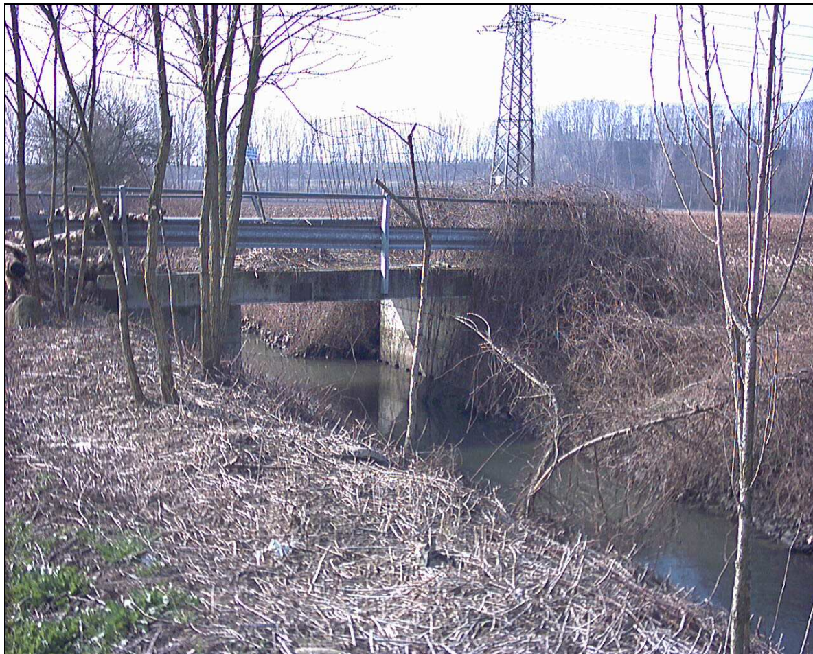
Figura 5 – Ponte 250 m a valle dell'autostrada
