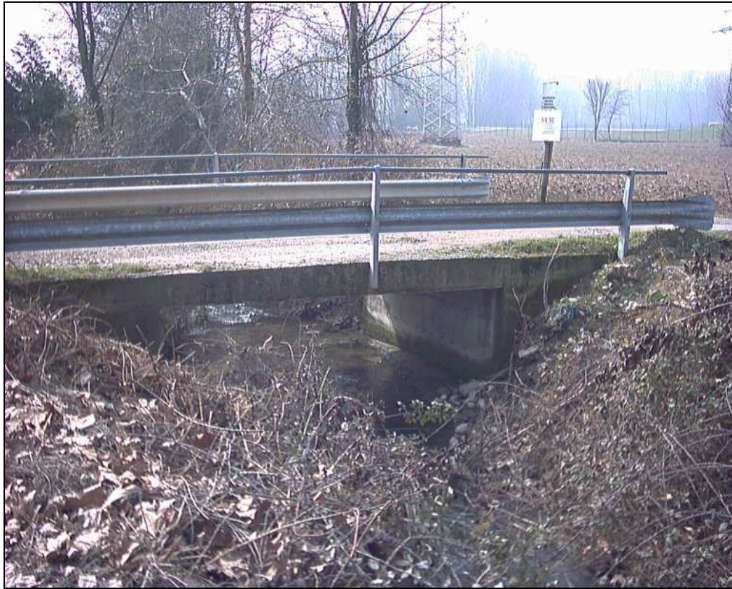
Figura 4 – Ponte 200 m a valle dell'autostrada
