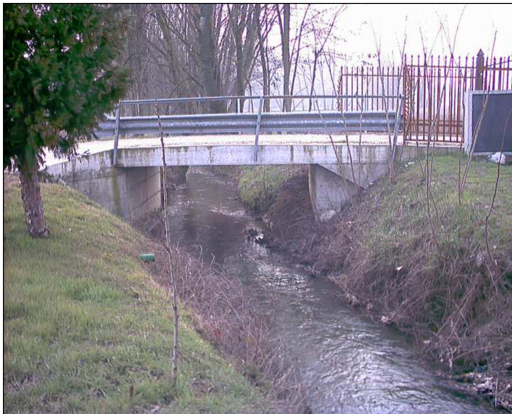
Figura 5 – Ponte 450 m a valle dell'autostrada
