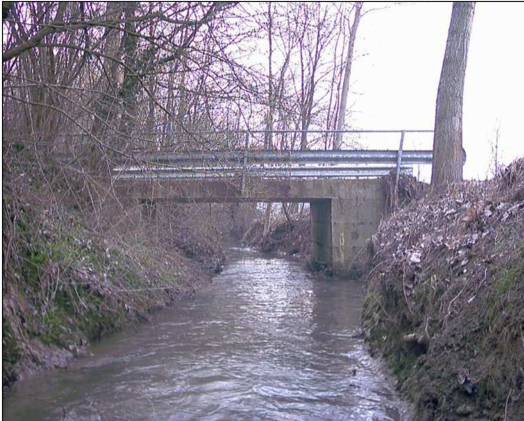
Figura 6 - Ponte a fine tratto
