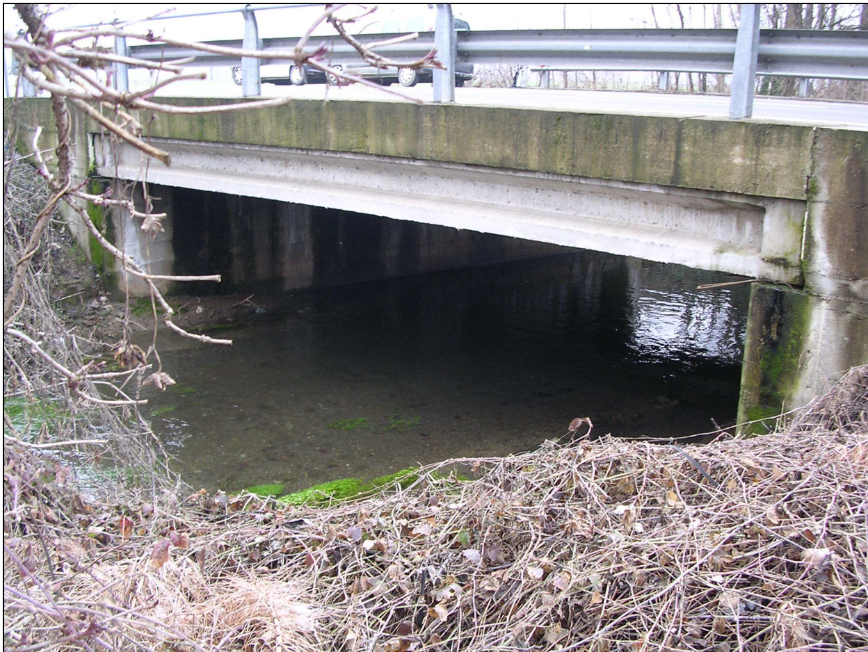
Figura 4 – Secondo ponte in calcestruzzo
