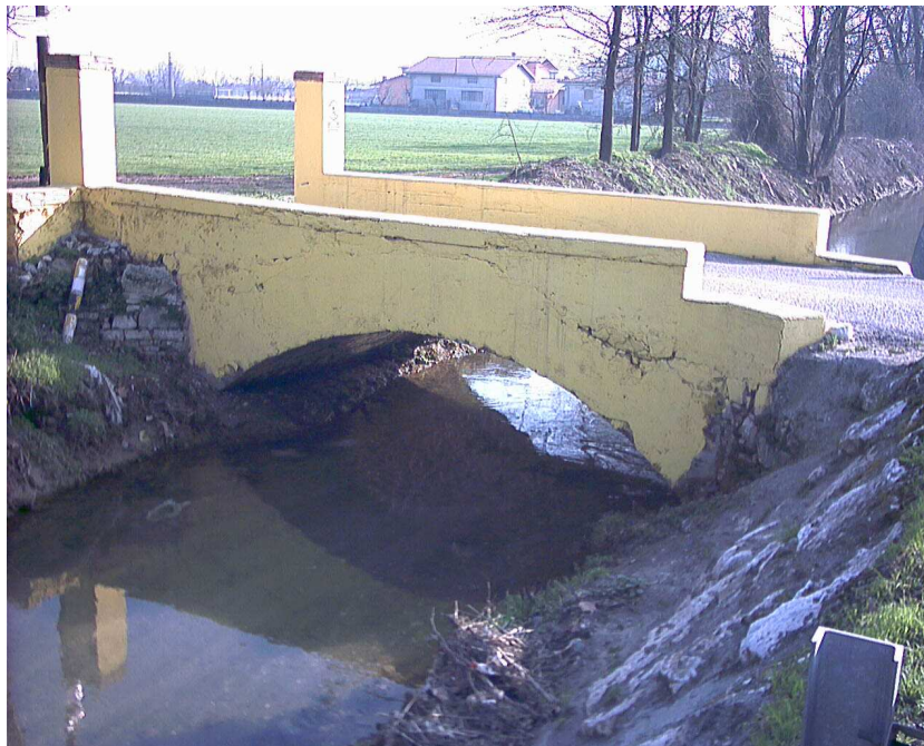
Figura 3- Opera 1 alla prog. 0+496.60
