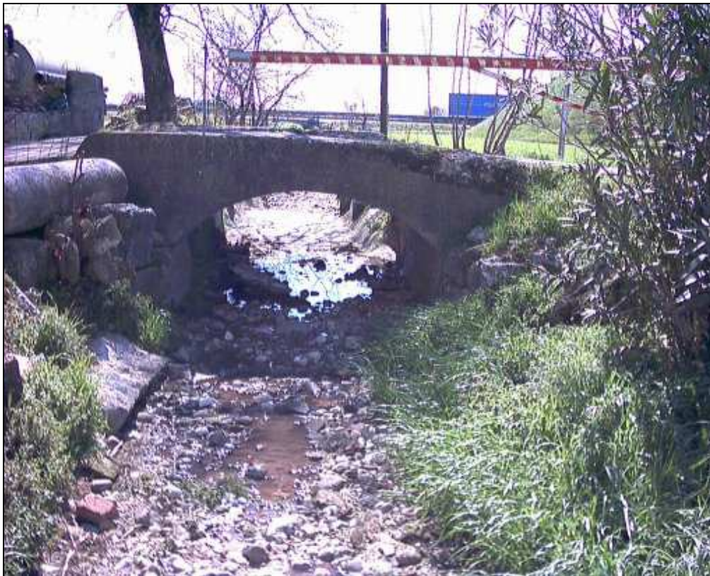
Figura 4 – Ponte a monte dell'autostrada
