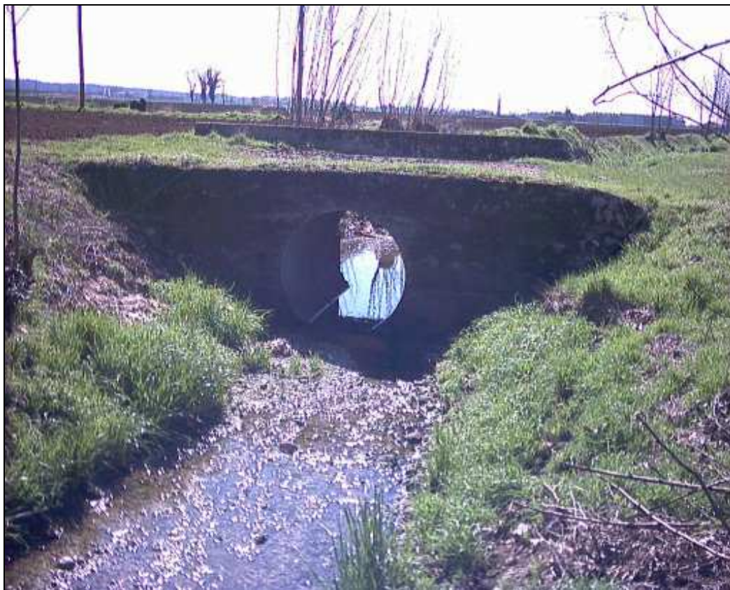
Figura 3 – Tombino a valle dell'autostrada
