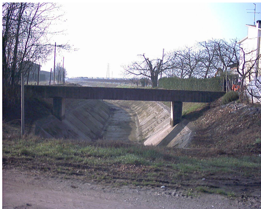
Figura 4- Ponte-canale a valle della linea storica
