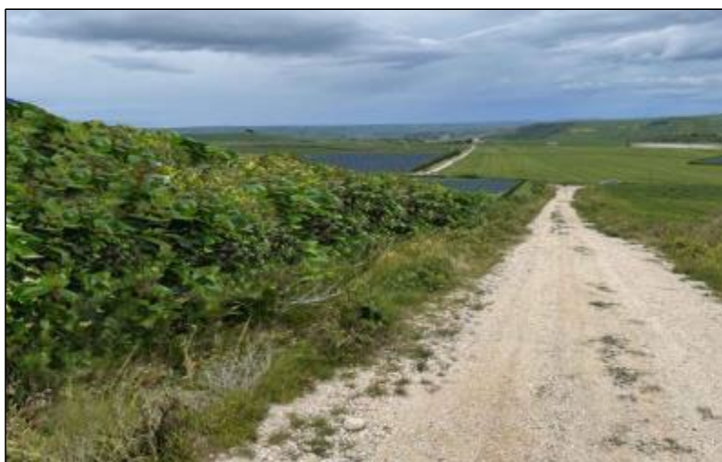
Figura 14 – Fotoinserimento (vista dalla strada di accesso a Badia Verticchio)
