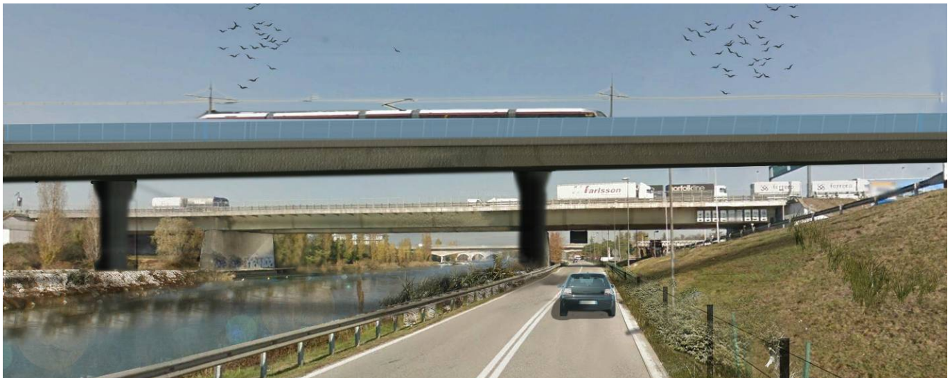
Figura 4-6- Viadotto sul fiume Mincio. Dall'alto in basso: inquadramento, vista dello stato di fatto, foto inserimento del progetto ferroviario (per le opere di mitigazione si rimanda al par. 4.3).
