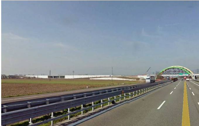
Figura 2-15 – Infrastrutture che attraversano le aree agricole tra Poncarale e Flero
