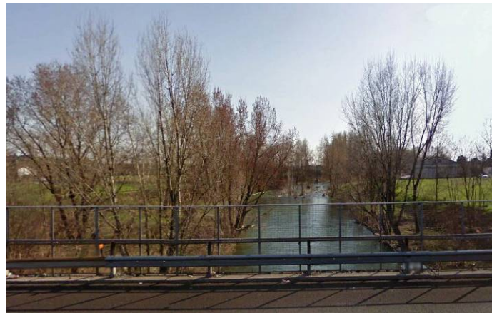
Figura 2-21 – Attraversamento del fiume Chiese dall'Autostrada A4
