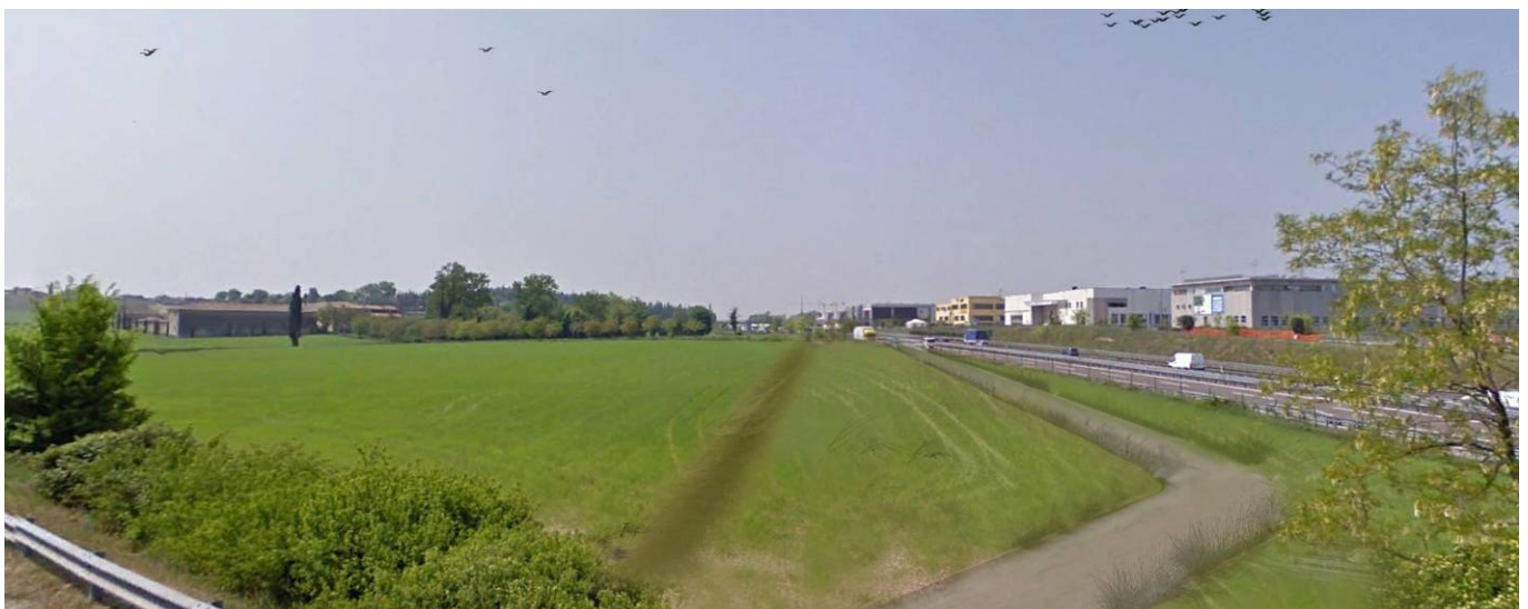
Figura 4-4- Copertura della galleria Frassinò. Dall'alto in basso: inquadramento, vista dello stato di fatto, foto inserimento del progetto ferroviario (per le opere di mitigazione si rimanda al par. 4.3).
