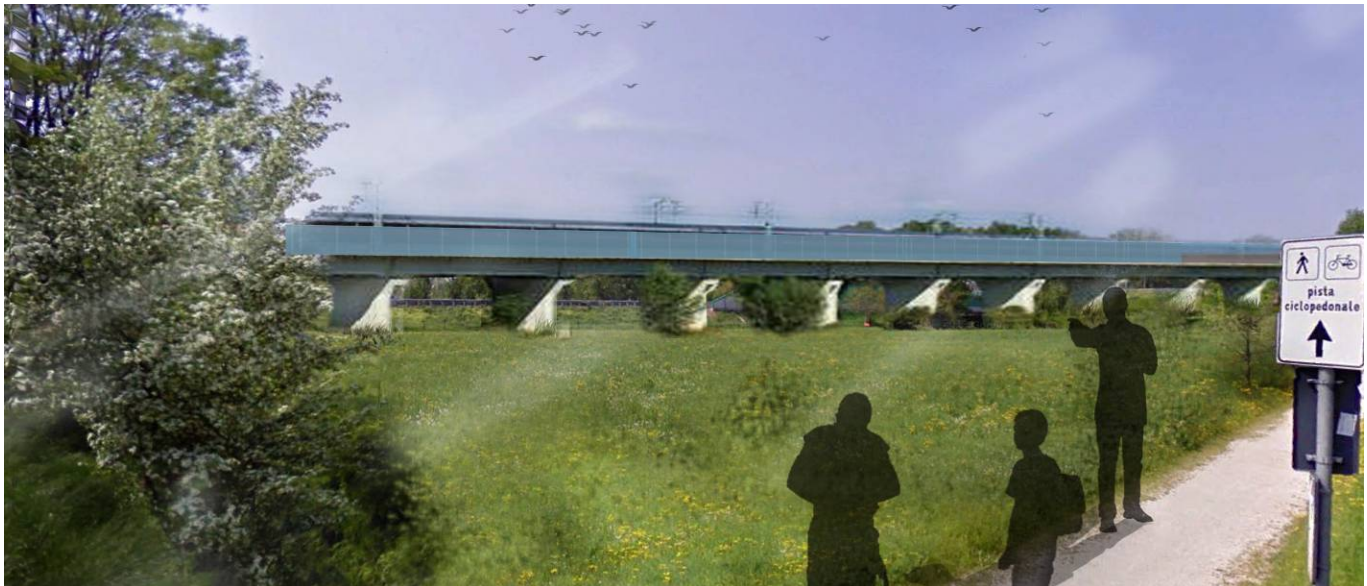
Figura 4-2- Tratto di linea ferroviaria in viadotto nella valle del fiume Chiese. Dall'alto in basso: inquadramento, vista dello stato di fatto, foto inserimento del progetto ferroviario (per le opere di mitigazione si rimanda al par. 4.3).
