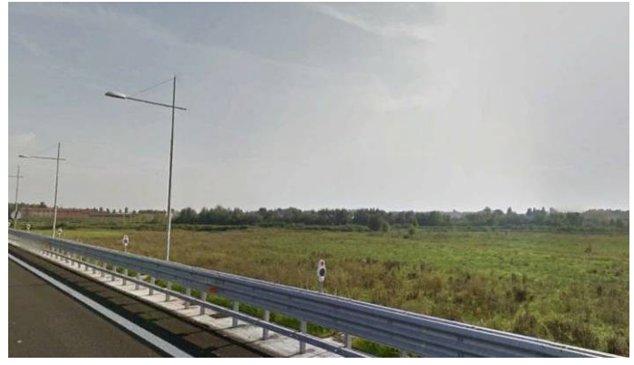
Figura 2-11 – Aree agricole a sud del raccordo Montichiari-Ospitaletto (in grigio nell'inquadratura su ortofoto), che verranno interferite dalla linea ferroviaria
