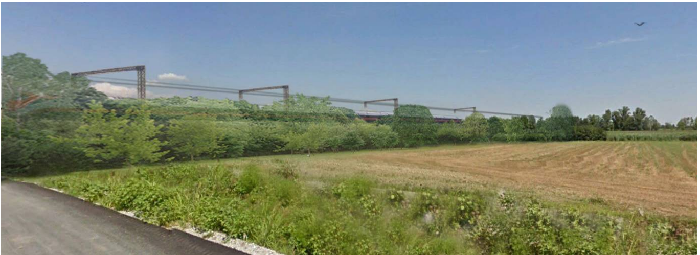
Figura 4-7- Tratto di linea ferroviaria in rilevato nel territorio comunale di Flero. Dall'alto in basso: inquadramento, fotoinserimento del progetto ferroviario, fotoinserimento del tracciato con le opere di mitigazione previste al fine di mitigare l'impatto visivo del rilevato e ricucire la rete della vegetazione (per le opere di mitigazione si rimanda al par. 4.3).
