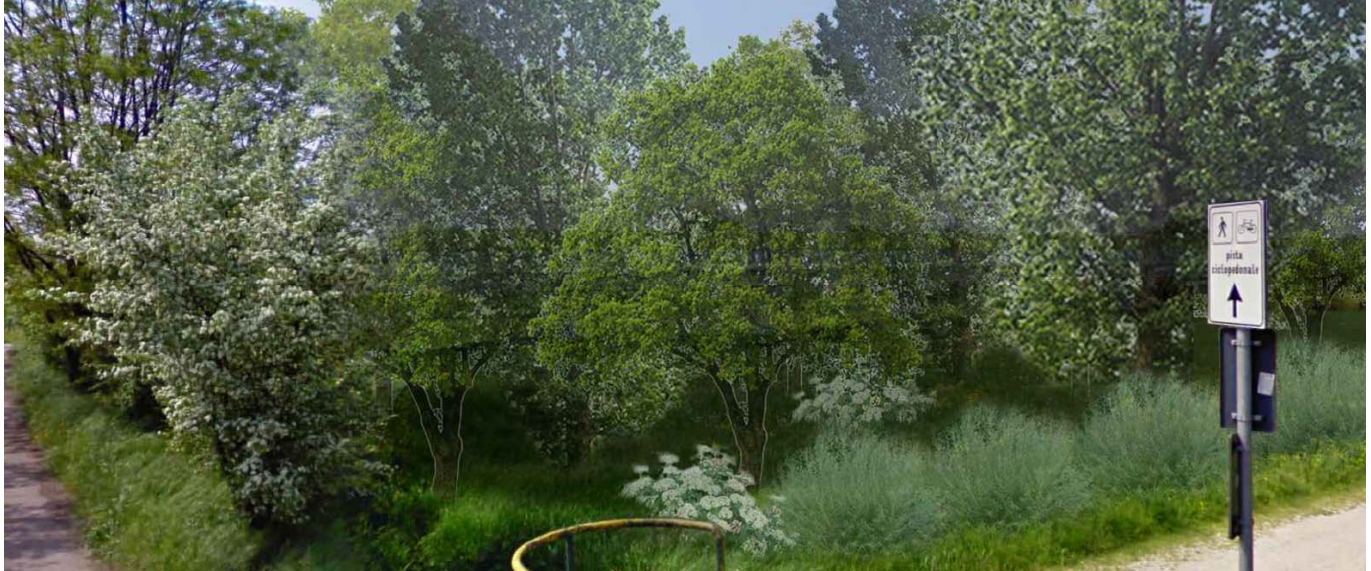
Figura 4-8- Tratto di linea ferroviaria in viadotto nella valle del fiume Chiese. Dall'alto in basso: inquadramento, fotoinserimento del progetto ferroviario, fotoinserimento del tracciato con le opere di mitigazione previste al fine di mitigare l'impatto visivo del viadotto (per le opere di mitigazione si rimanda al par. 4.3).
