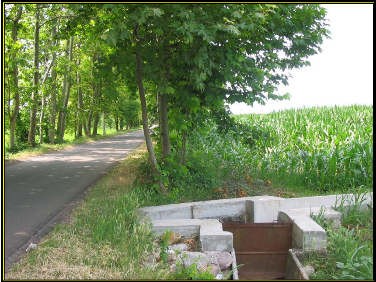
Figura 18: fotografia di via Rossa; sulla destra una porzione del sedime del cantiere L.3.O.3.
