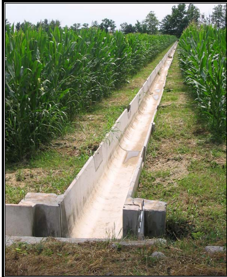
Figura 17: fotografia del sedime del cantiere (al centro la roggia irrigua interferita)
