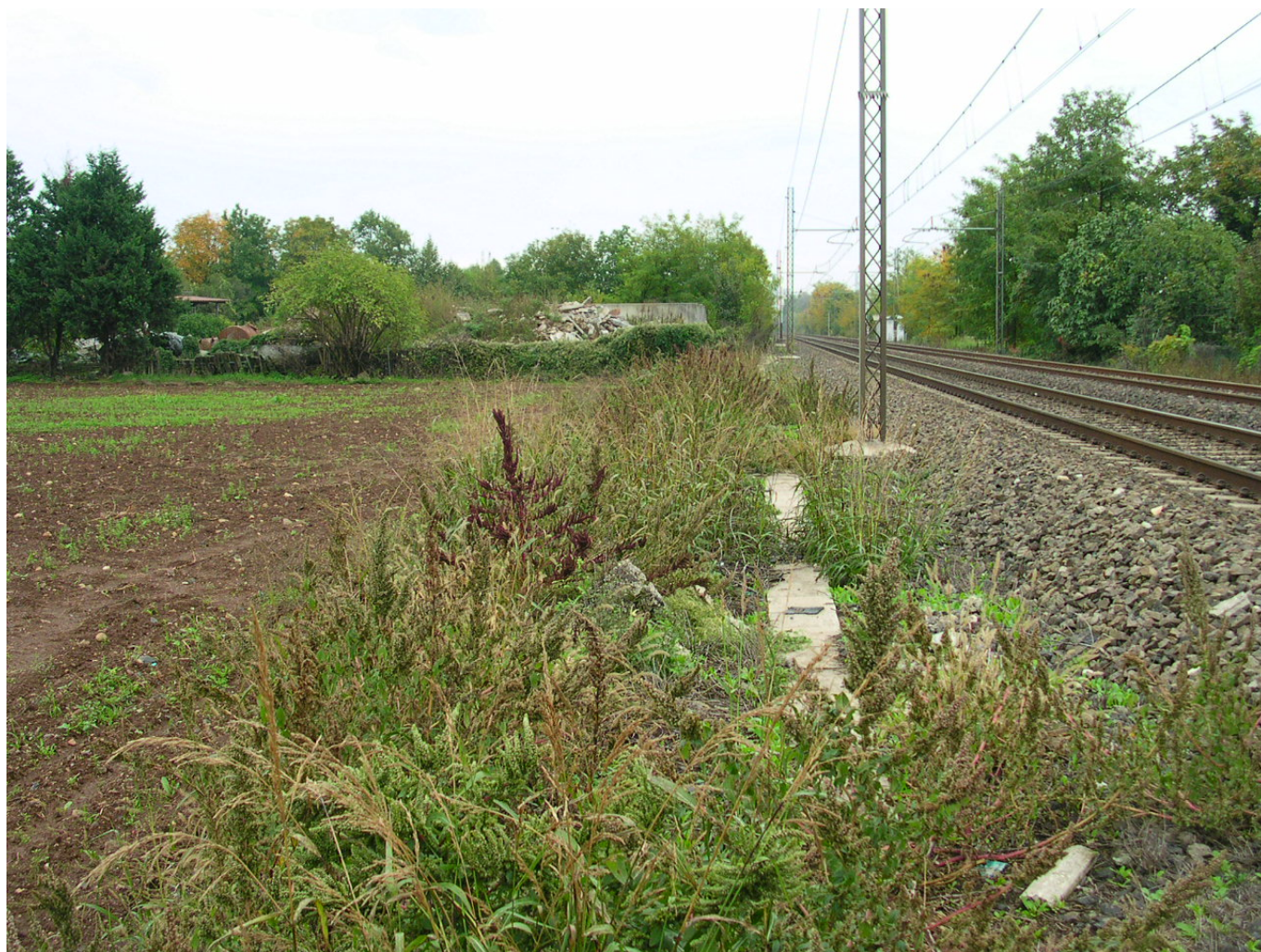
Foto n°2 – Particolare Linea Storica MI-VR Pk. Alla Pk 94+008 BD Direzione Milano
