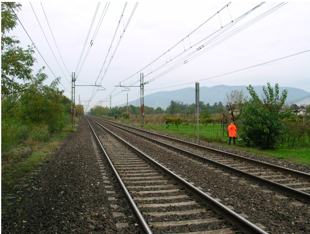
Foto n°1 – Particolare Linea Storica MI-VR Pk. 94+780 c.a Direzione MI
