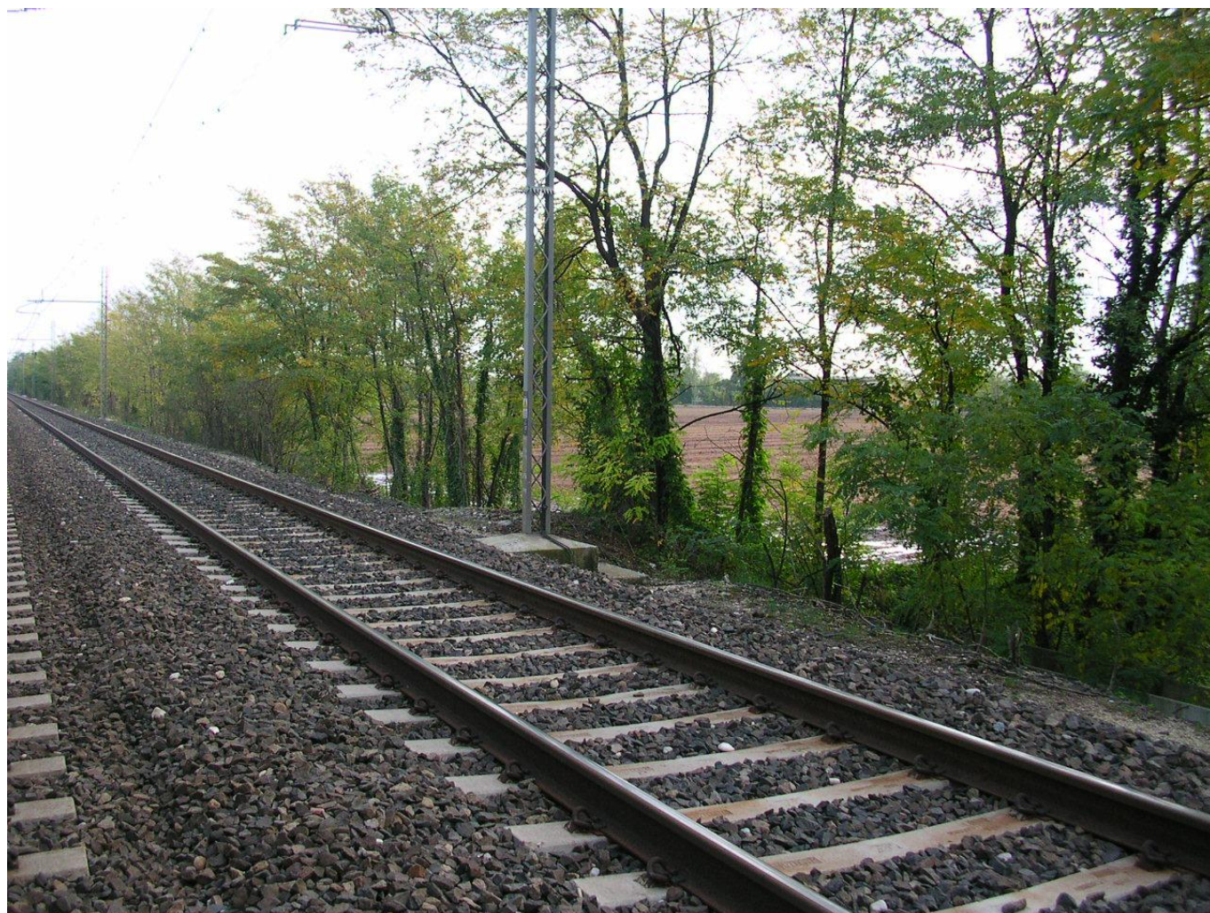
Foto n°1 – Particolare zona affiancamento alla Linea Storica direzione VR alla Pk l.s. 135+000 c.a.
