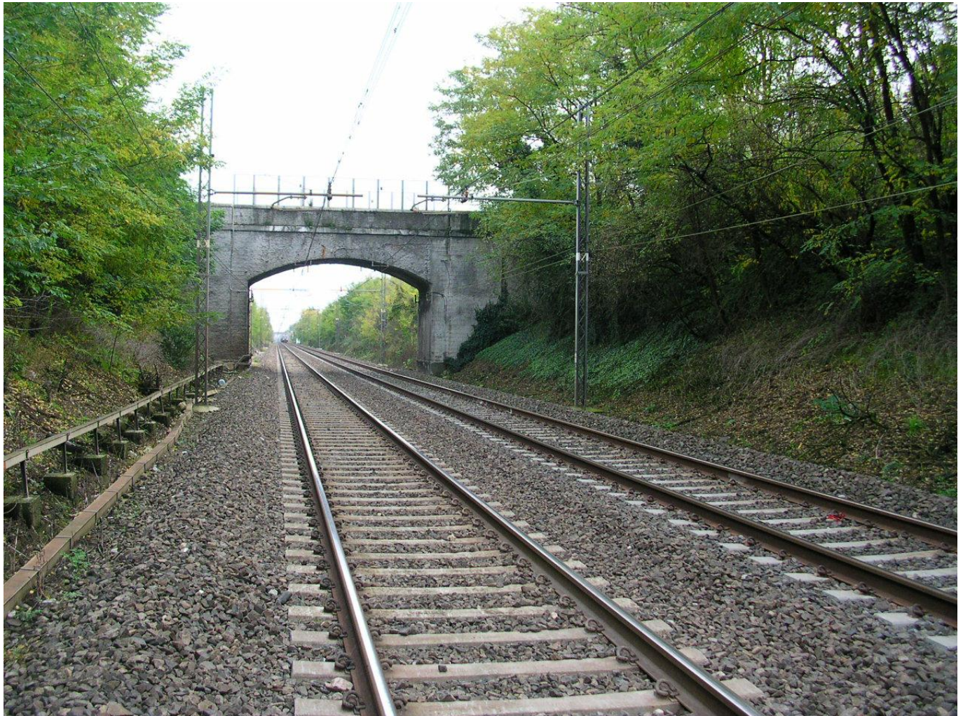
Foto n°1 – Particolare Linea Storica MI-VR Pk. 94+600 c.a in corrispondenza zona varo spingitubo Direzione Verona
