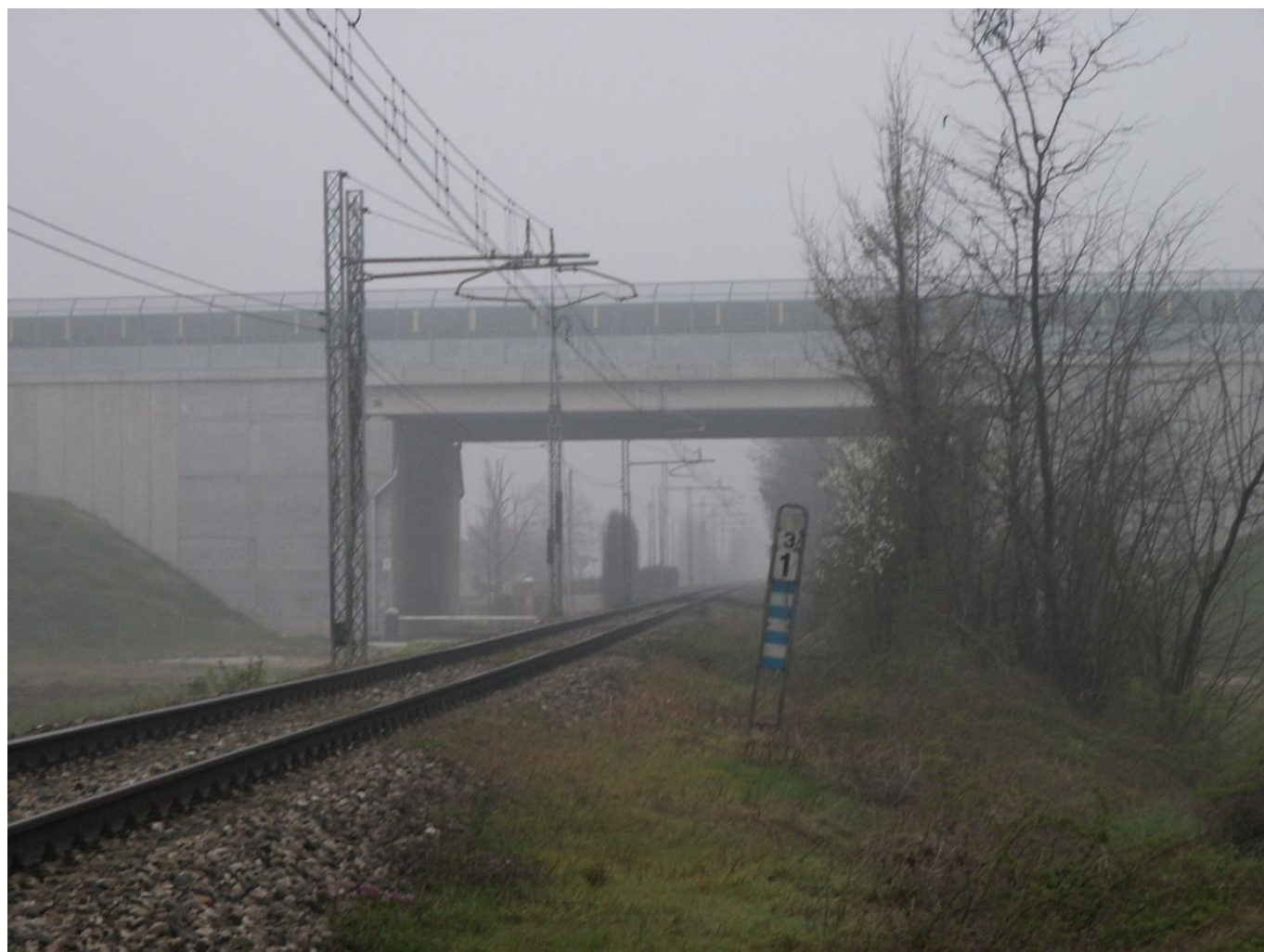
Foto n°1 – Particolare Linea Storica Olmeneta-Brescia direzione BS in corrispondenza del futuro PLA
