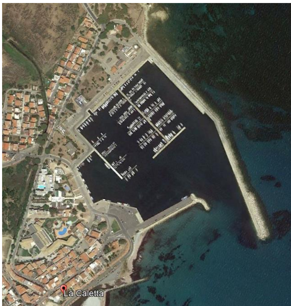
Figura 2 Foto zenitale della struttura portuale
