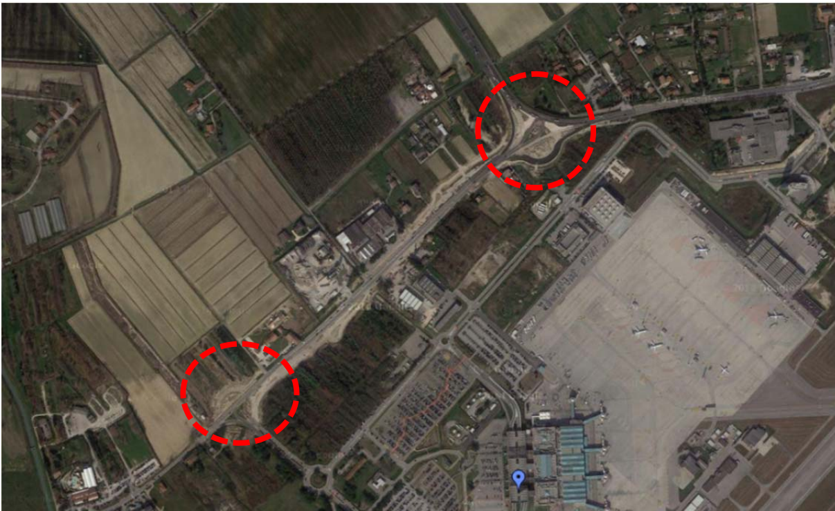
Figura B2-20 SS14 Triestina: sono evidenziati i lavori sulle due rotatorie, all'ingresso dell'aeroporto e all'intersezione con la bretella autostradale.
