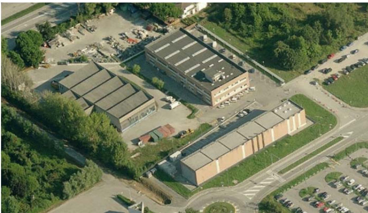
Figura B2-35 Area tecnica e centrale tecnologica, vista dall'alto – stato di fatto.
