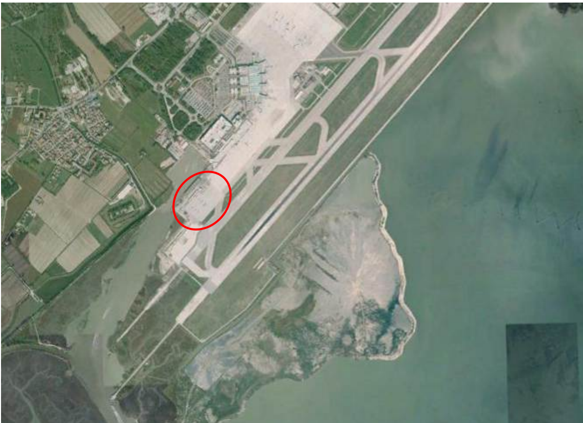
Figura C4-36 Ubicazione della piazzola di de-icing, nelle vicinanze della testata pista 04L. Foto da satellite Google Earth 2014.
